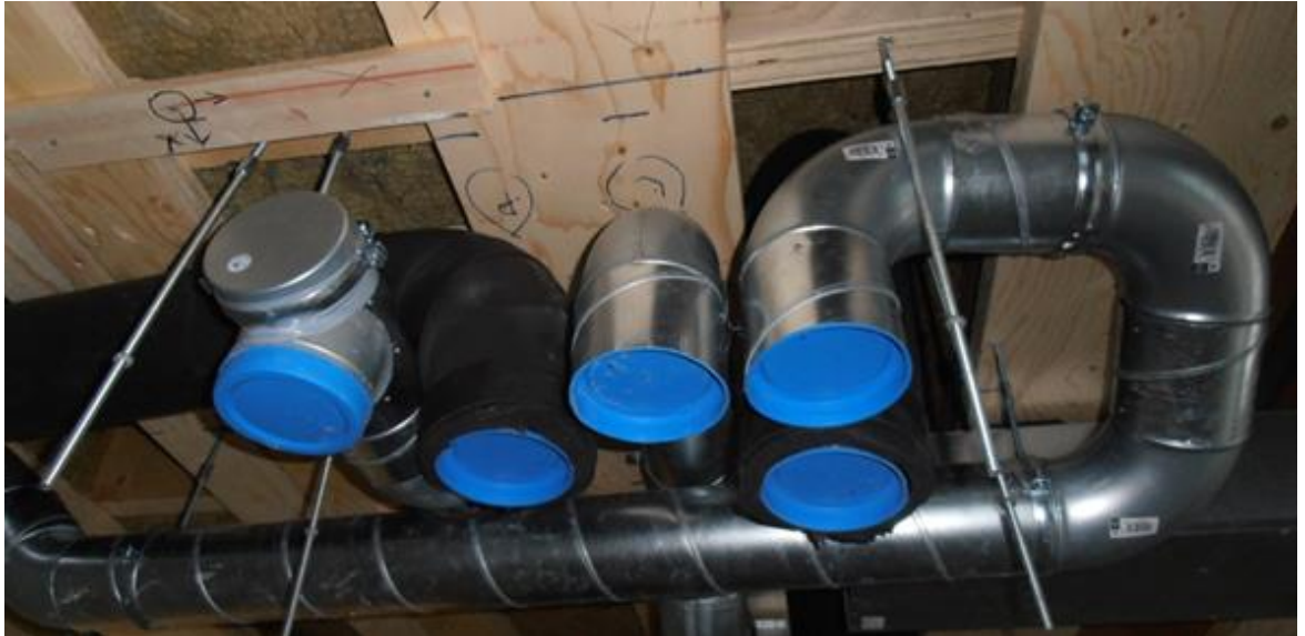
Kuvio 14. Ilmanvaihtokojeen putkisto (Metsä Wood, [viitattu 26.4.2014]).
