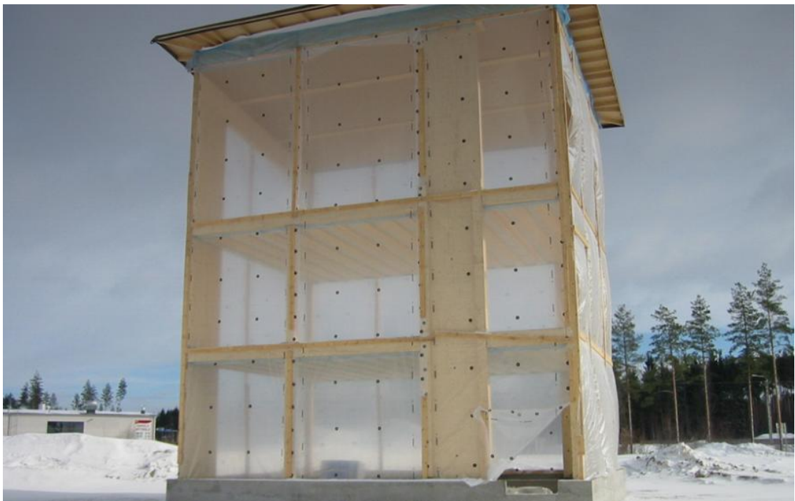
Kuvio 15. Rakennuksen huputus (esimerkkikuva) (Metsä Wood, [viitattu 22.4.2014]).
