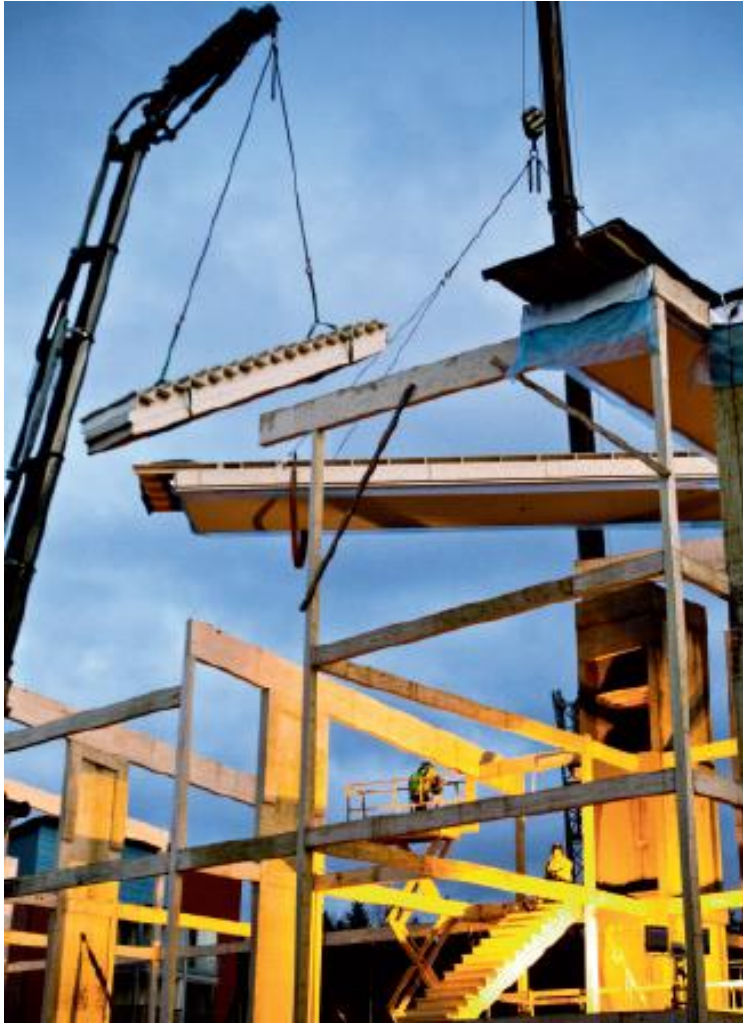
Kuvio 10. Porras- sekä kattoelementin nosto (Puuinfo, [viitattu 31.3.2014]).
