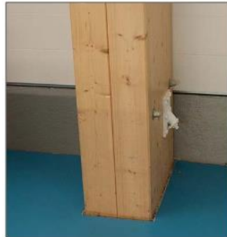
Kuva 5. Liimaruuviliitos pillossa valmiin lattiapinnan alla
