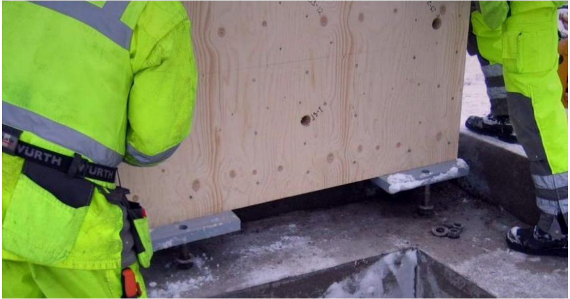
Kuvio 7. Mastojäkisteen asennus (Metsä Wood, [viitattu 19.3.2014]).
