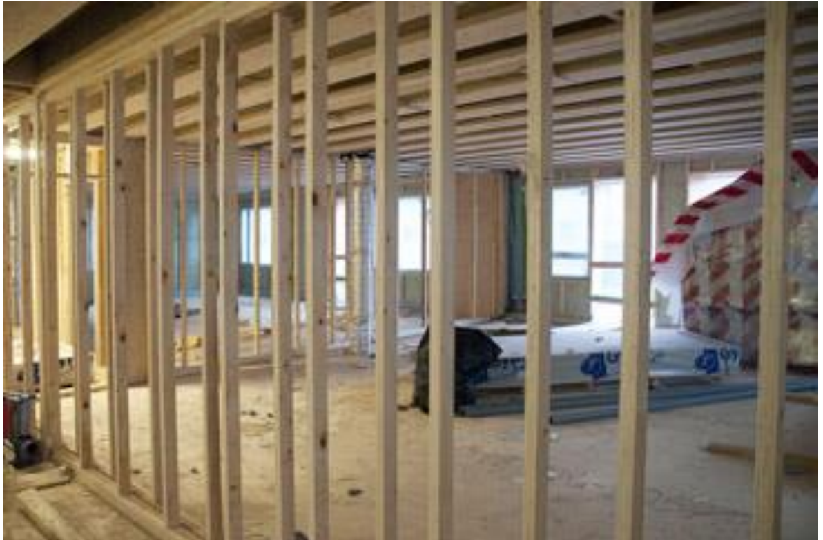
Kuvio 18. Kerto-T-tolppa kaksinkertaisen seinän rankamateriaalina (Metsä Wood, [viitattu 3.4.2014]).
