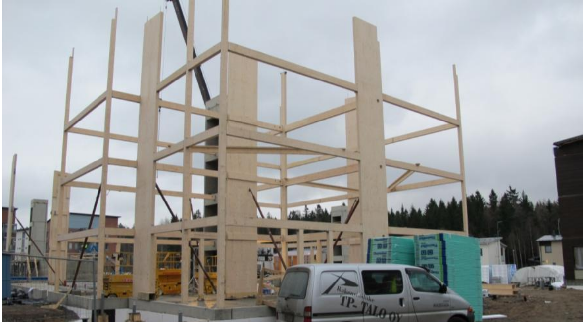
Kuvio 9. Pilari-palkkirunko kattopalkkeja vaille valmis (Metsä Wood, [viitattu 19.3.2014]).
