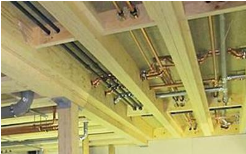
Kuvio 13. Kerto-Ripa-lattiaelementeissä on läpiviennit talotekniikkaa varten (Metsä Wood, [viitattu 3.4.2014]).
