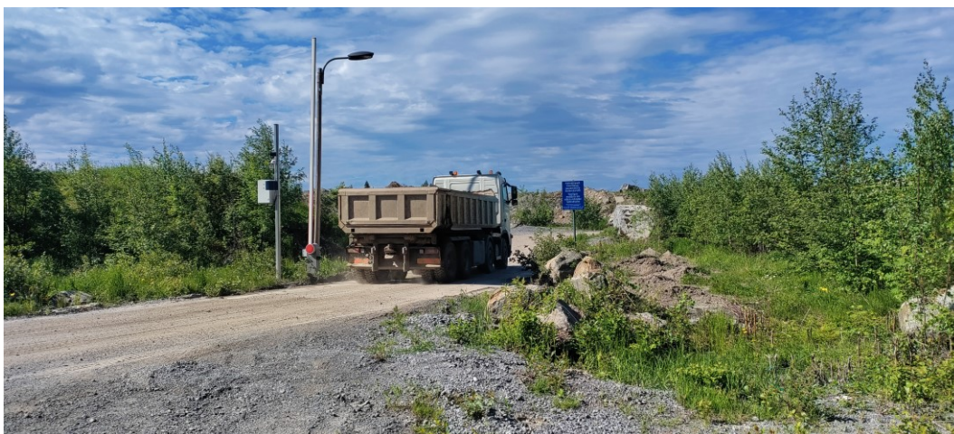
Kuva 19. Öjen maisemarakennuskohteen portti ja ylijäämämaakuorma.
