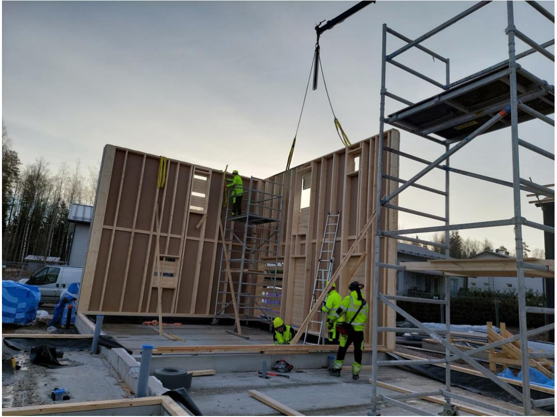
Kuva 2 paikalla rakennettujen elementtien pystytys ennen villoitusta ja höyrynsulun asennusta
