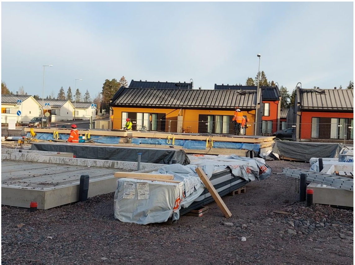
Kuva 7 ulkoseinäelementtien rakentamista perustusten päällä
