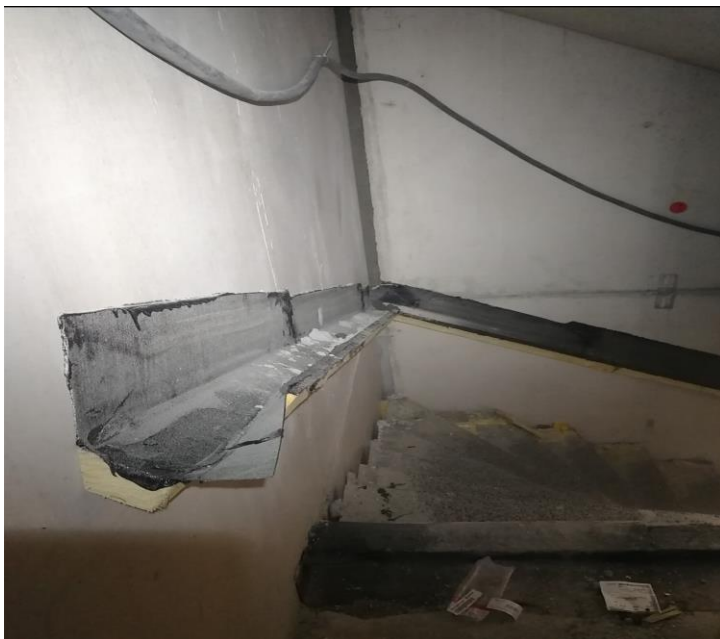
Kuva 9. Kuvassa kohteessa tehty väliaikainen vesikatko porrashuoneen rappusiin, jonka alapuolella on vesisäiliö keräämässä mahdollisia vesiä.
