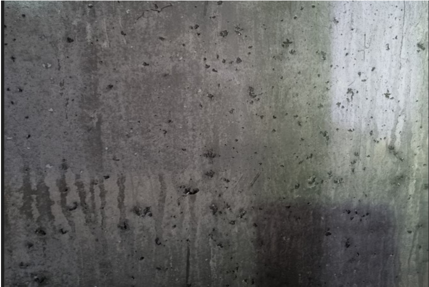
kuva 13. Väliseinän huokokset
