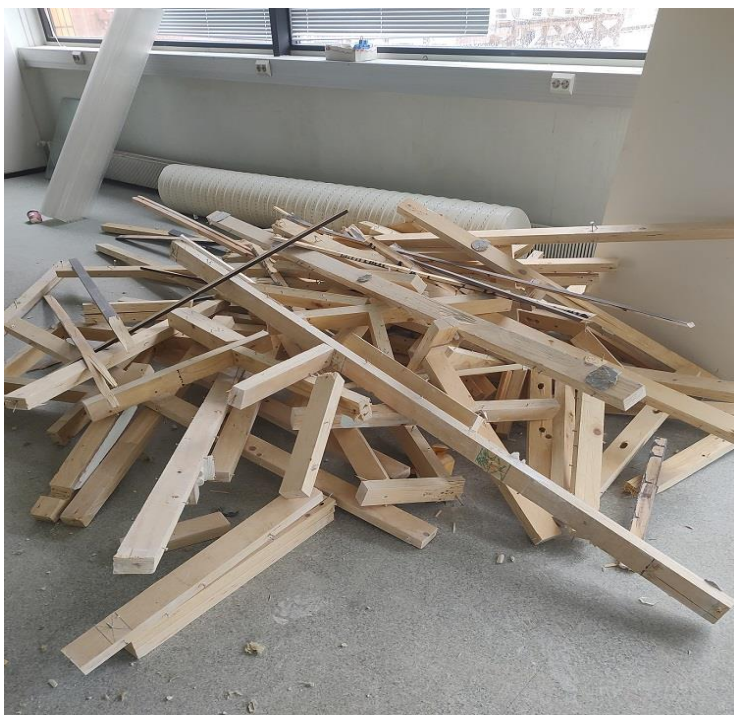
Kuva 5. Purkupuukasa työmaalla, sisältää pieniä määriä nauloja sekä naulauslevyjä.
