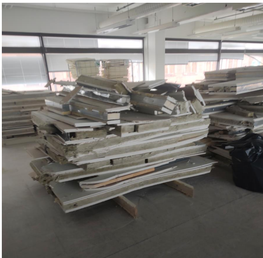
Kuva 4. Rakennusjäte lk2 kriteerit täyttävä purkujätekesä.
