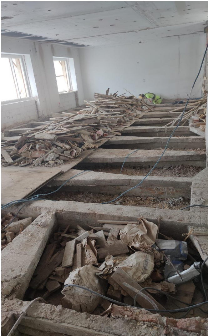
Kuva 2. Esimerkkikuva sisäpurkutyömaalta. Käynnissä lattia-arkkujen puhdistus.
