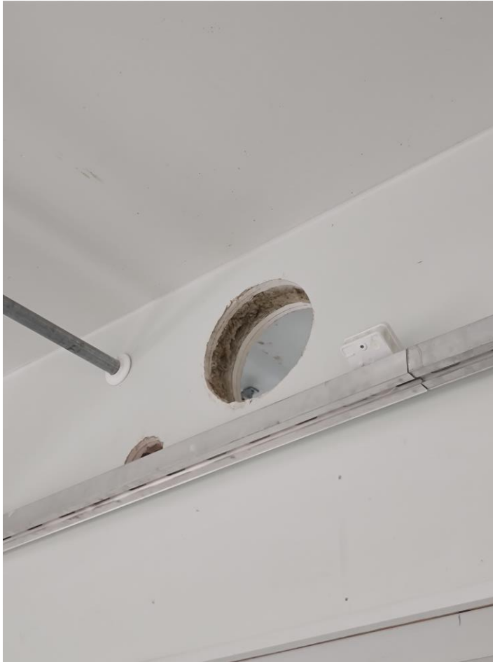
Kuva 11. Seinästä irrotetun iv-kanavan aukosta näkyvä rakenne. Tupla kipsilevy ja välissä lasivilla.
