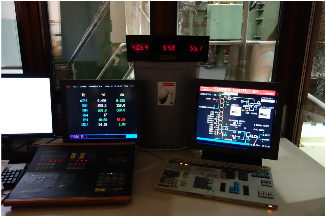
Kuva 13. Superkalanterin 4 ohjausjärjestelmä. Vasemmalla Sentryn ja oikealla Alcontin näyttö ja näppäimistö.
