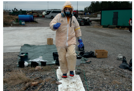
Kuva 10.6 ja 10.7 Keräystyömaan mallikuva ja esimerkki kulkureittien suojauksesta imeytysmatolla (Valokuva O. Kilpeläinen 2009).
