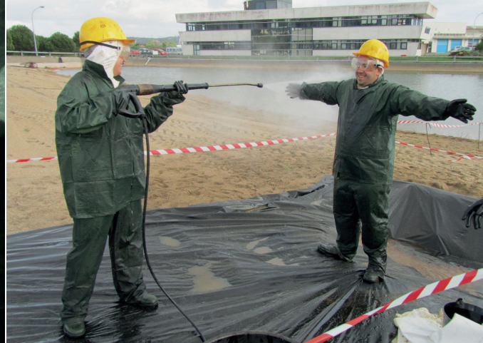
Kuva 10.16 ja 10.17 Puhdistautumispisteessä käytettäviä menetelmiä. Oikean puoleisessa kuvassa näkyy valumavesiä varten rakennettu keräyskuoppa (M. Pascale 2010).
