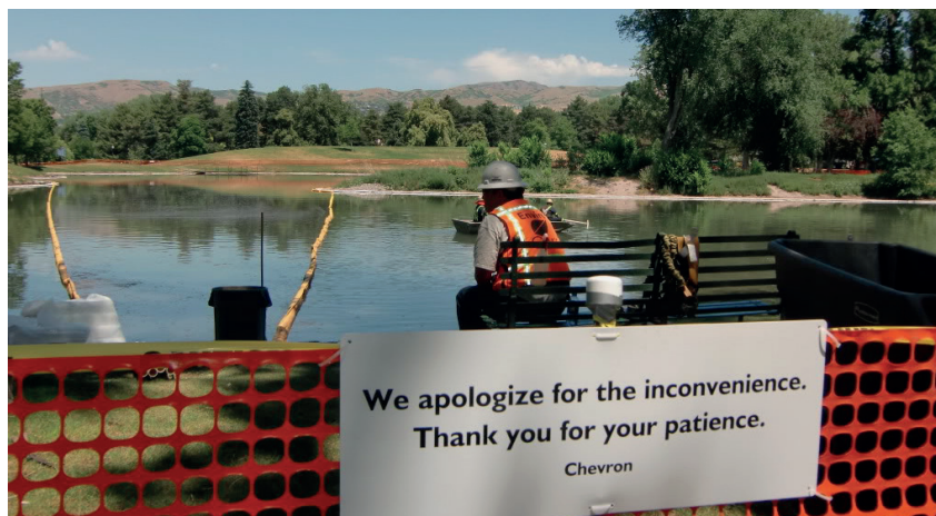
Kuva 18.1 Keräystyömaa on eristettävä ( www.photobucket.com ).
