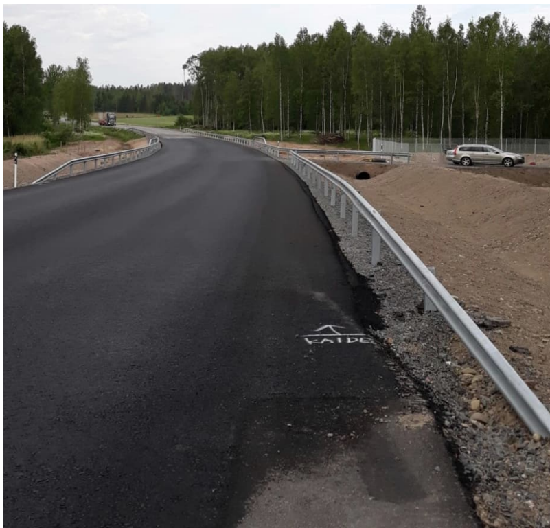
Kuva 11. Valmis tierakenne. (Destia Oy, 2020)
