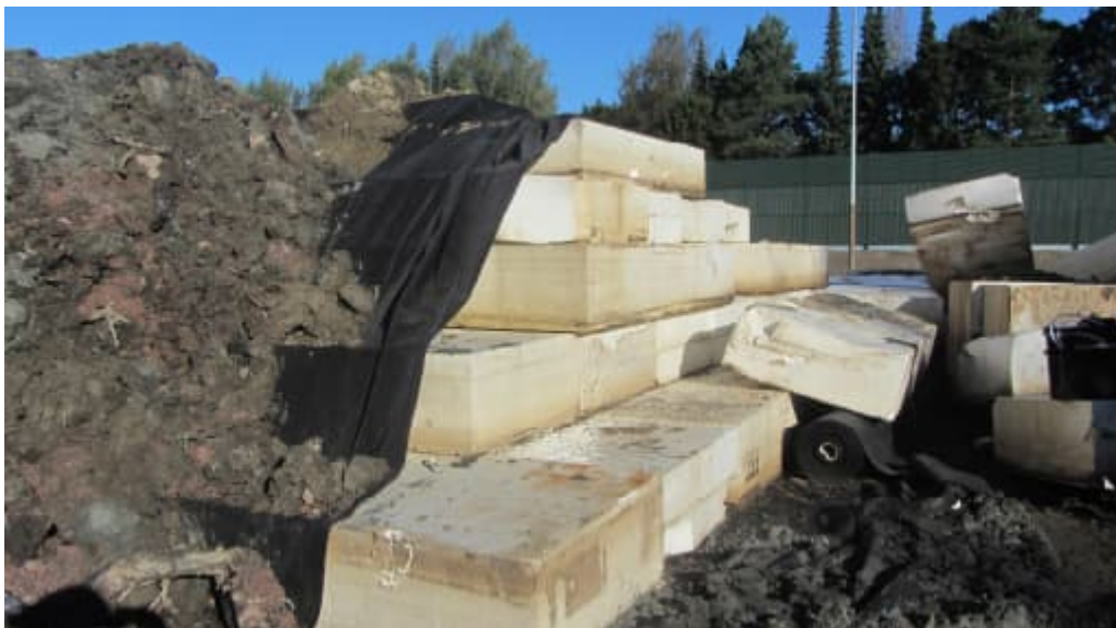
Kuva 4. Penkereen rakentaminen EPS- harkoista. (Kuva: Gustafsson, H., 2017)
