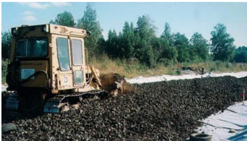
Kuva 6. Tien korottamista rengasrouheella. (Suomen rengaskierrätys Oy. 1997)
