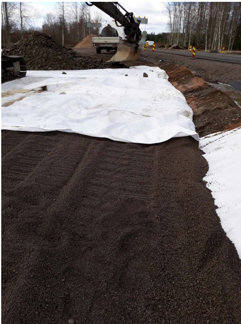
Kuva 2. Kevytsorapenkereen tiivistämistä.
