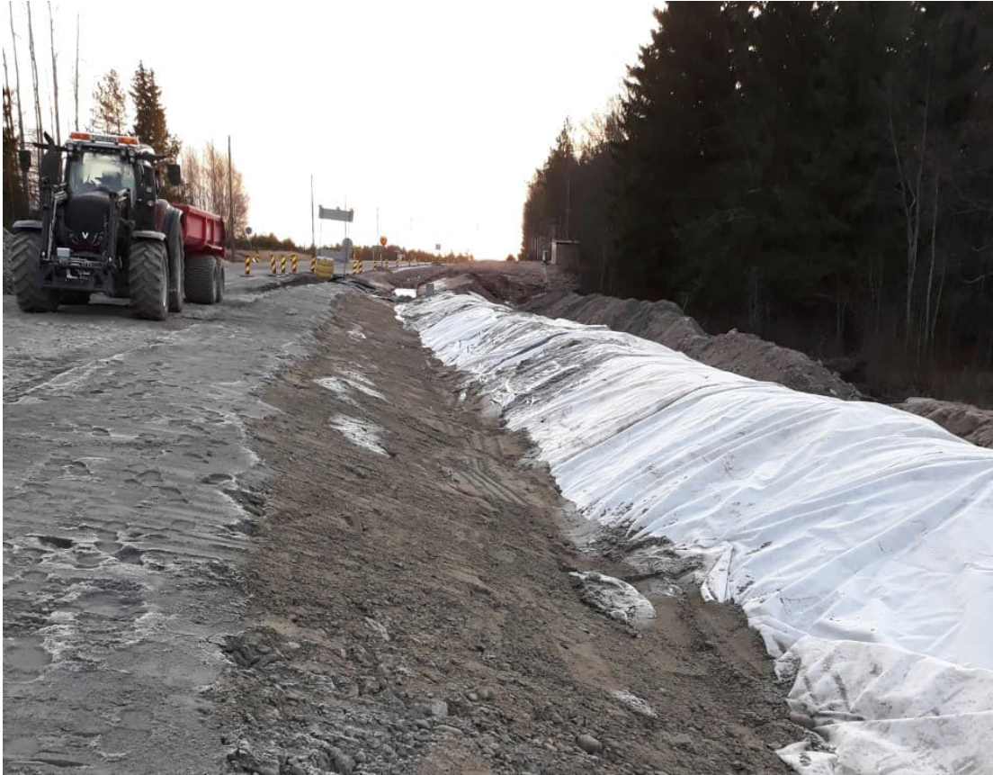
Kuva 12. Vastapenger rakennusvaiheessa. (Destia Oy, 2020)
