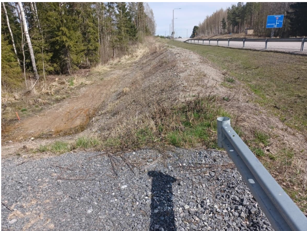
Kuva 16. Kevytsorasta rakennettu penger.
