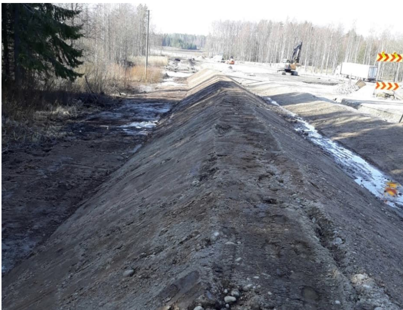
Kuva 13. Valmis vastapenger. (Destia Oy, 2020)
