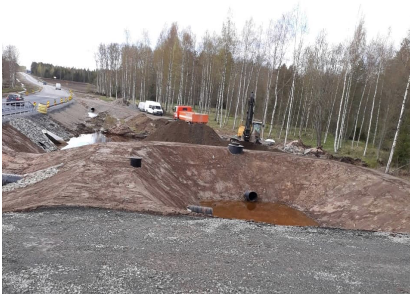
Kuva 14. Valmis viivytyssallas. (Destia Oy, 2020)
