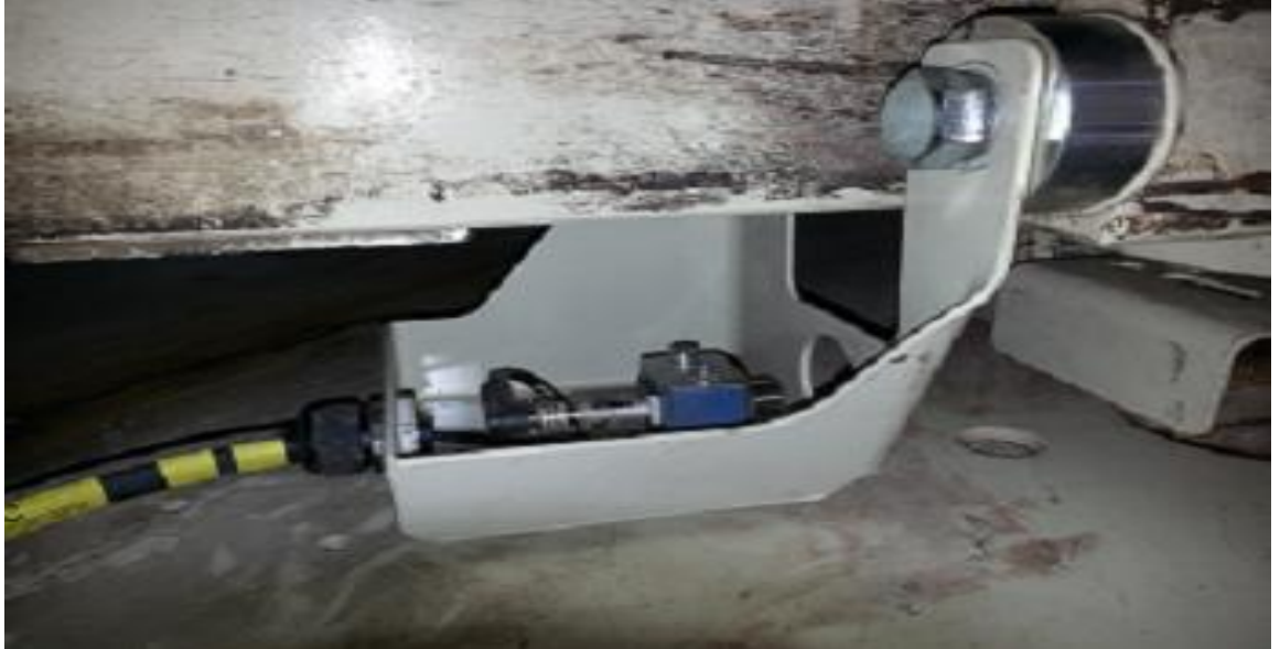
Kuva 25. Asetusanturi ja kiinnitysteline asennettuna.
