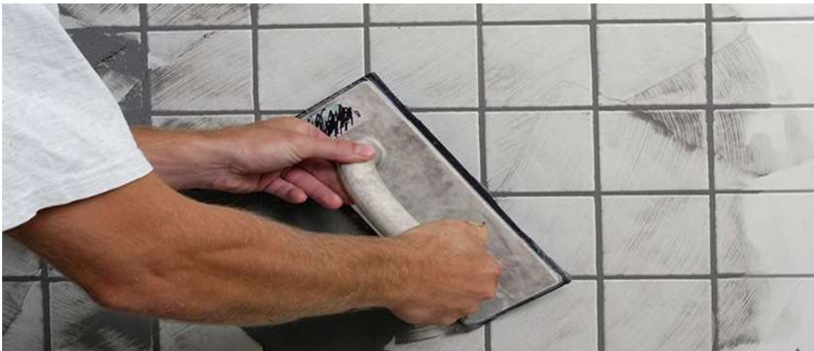
Kuva 13. Saumalaasti levitetään saumoihin saumauslastalla (Kymppilattiat.)
