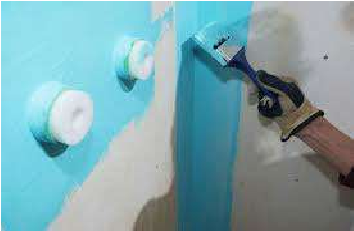
Kuva 9. Kuvassa vesieristetään läpivientejä sekä nurkkia (Rakentaja.)
