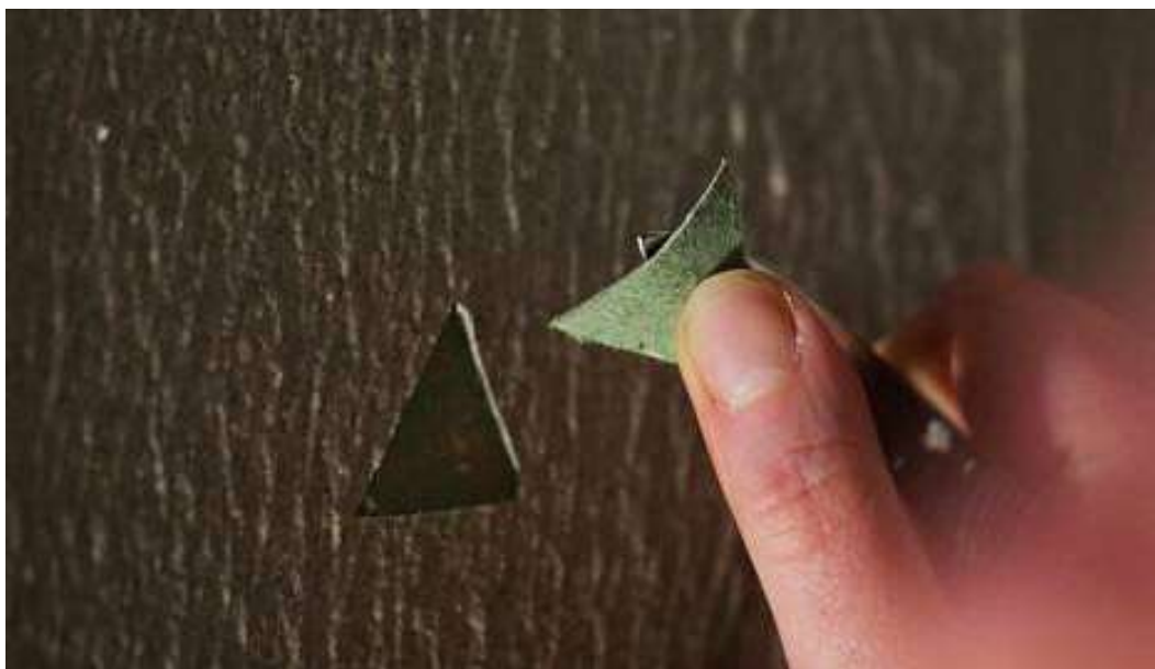
Kuva 8. Kuvassa otetaan vesieristeestä koepala paksuuden mittaamista varten (Takala, 2016.)
