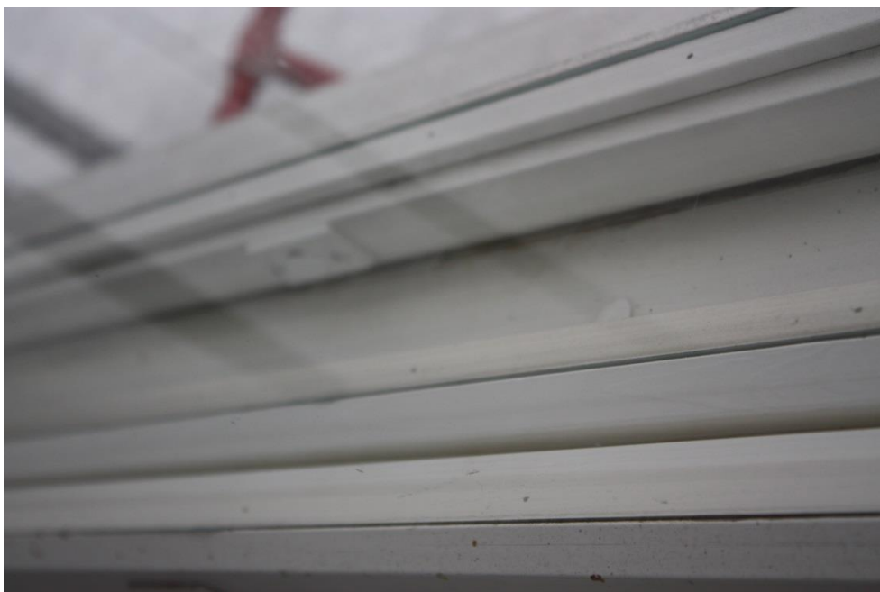
Kuva 7b. Ikkunat ovat pääosin tyydyttävässä kunnossa
