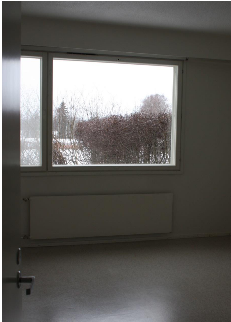
Kuva 7a. Ikkunat ovat kolmilasisia MSK-ikkunoita
