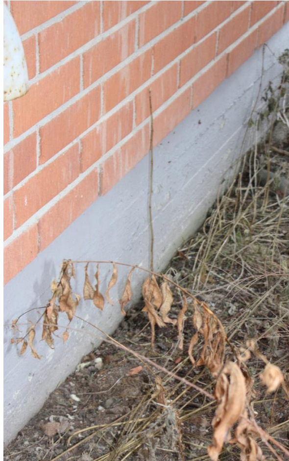
Kuva 6. Rakennusten sokkeli on pääosin hyväkuntoinen
