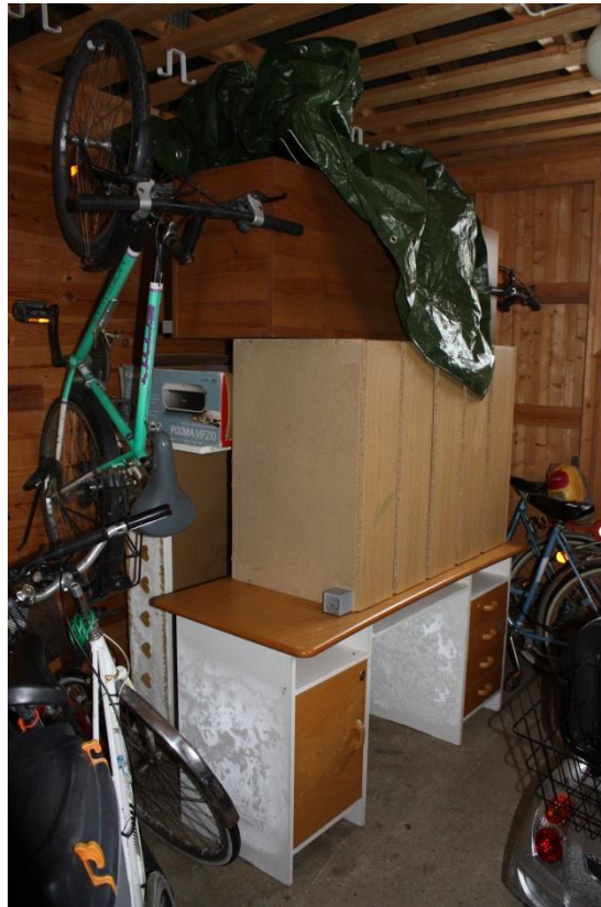
Kuva 5. Erillisen varistorakennuksen pyörävarastossa on sinne kuulumattomia tavaroita
