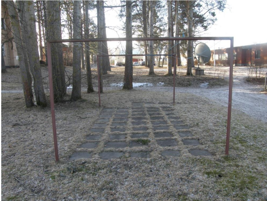
Kuva 3. Tomutus- ja pyykinkuivaustelineiden betonilaatoitus on pahoin nurmettunut
