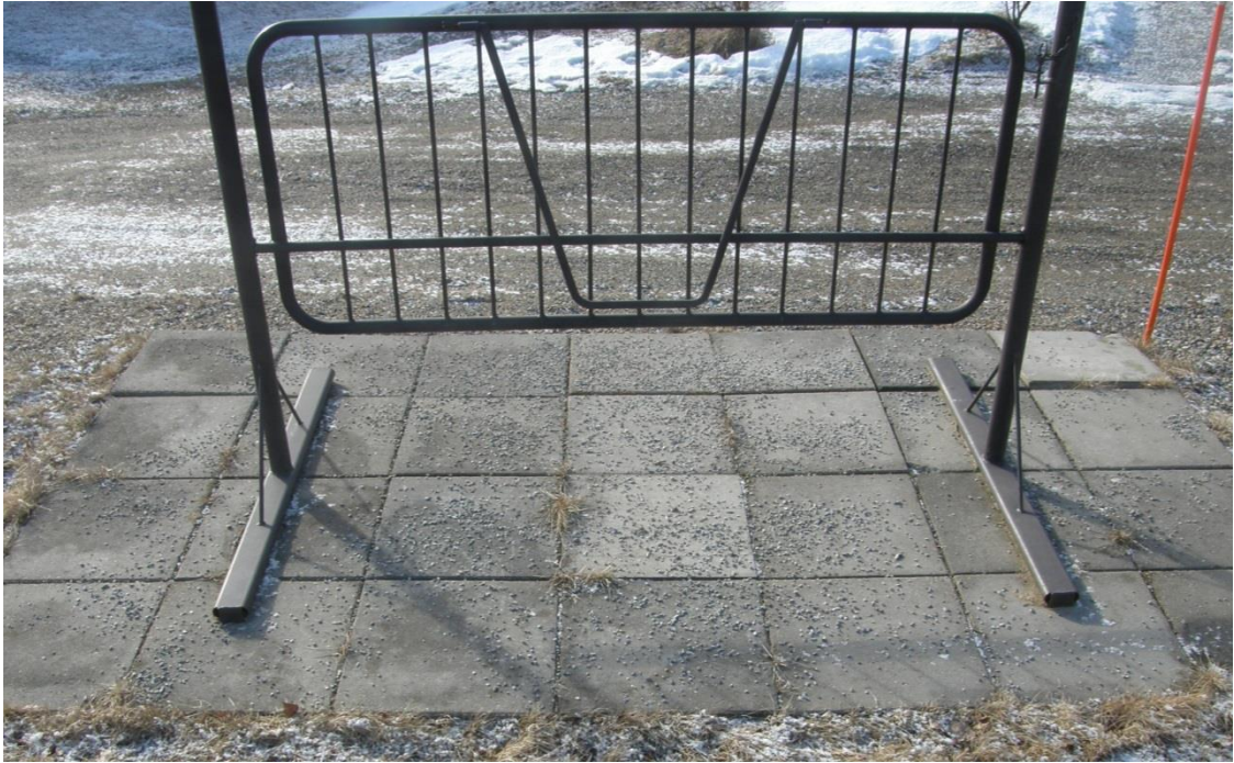
Kuva 6a. Tomutustelineet ovat hyväkuntoiset.
