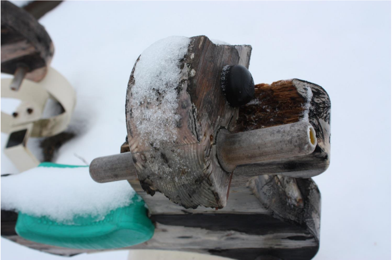
Kuva 7. Osa leikkivarusteista on epäkunnossa. (Keinuankan pää on lahonnut ja rikkoutunut)
