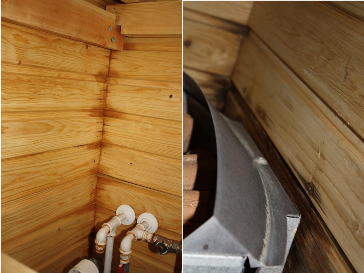
Kuva 15a. Huoneistosaunojen paneelit ovat tummuneet kiukaan takaa ja nurkista.
