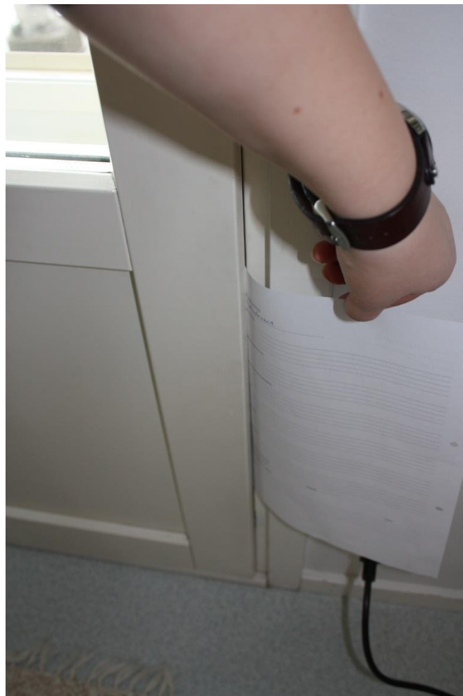
Kuva 12. Parvekkeen ovissa on asukaskyselyn mukaan tiiveys-, sulkemis- ja avaamisongelmia. Kuvan ovessa on A4-arkin mentävä rako.
