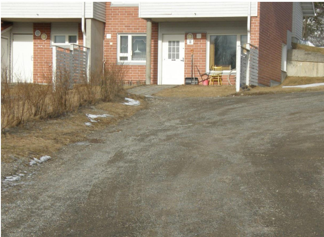
Kuva 2a. Paikoitusalueella on havaittavissa pintaveden tekemiä uomia.
