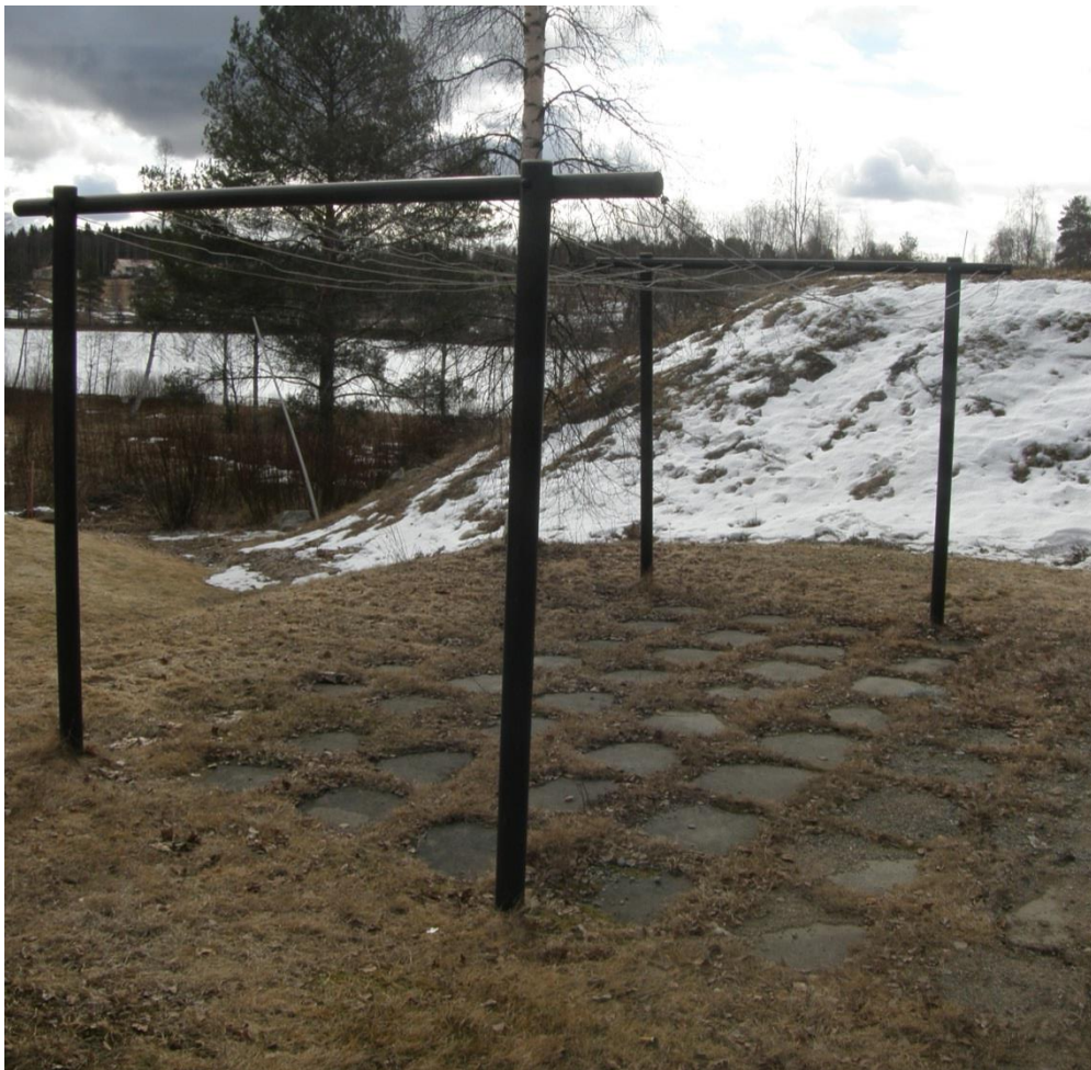
Kuva 6b. Pyykinkuivausteline on hyväkuntoinen rungoltaan, mutta narut kaipaavat uusimisen.
