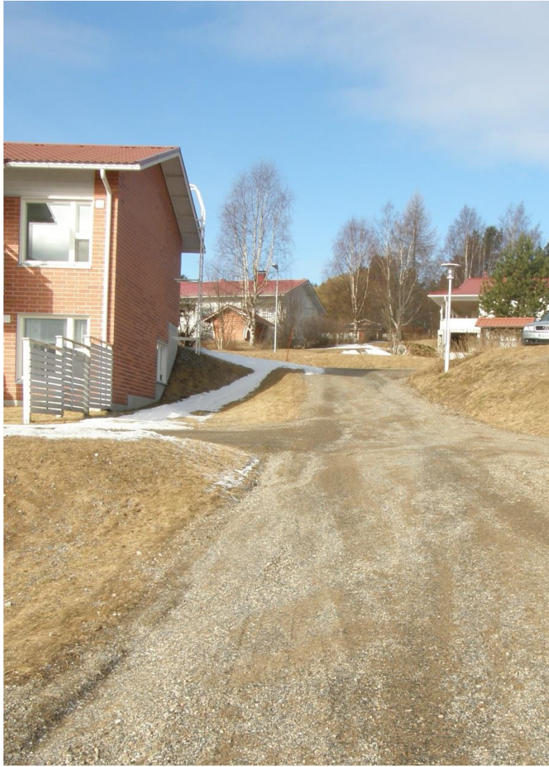
Kuva 2b. Jalankulkualueella on havaittavissa pintaveden tekemiä uomia.
