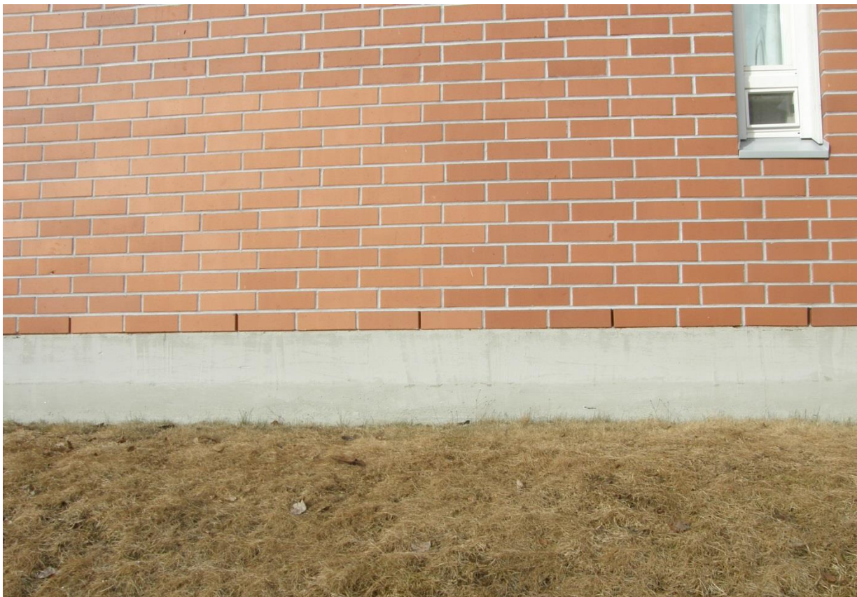
Kuva 10. Sokkeli on hyväkuntoinen.
