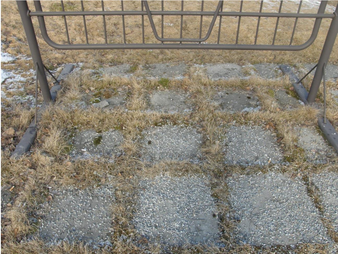
Kuva 4. Tomutus- ja pyykinkuivaustelineiden alla on betonilaatoitus. Osa betonilaatoituksista on ruohottunut.
