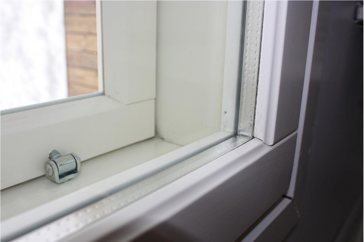
Kuva 11. Ikkunat ovat kolmilasisia MSE-ikkunoita. Ikkunoiden U-arvo on noin 1,4 \text{ W/m}^2\text{K} .
