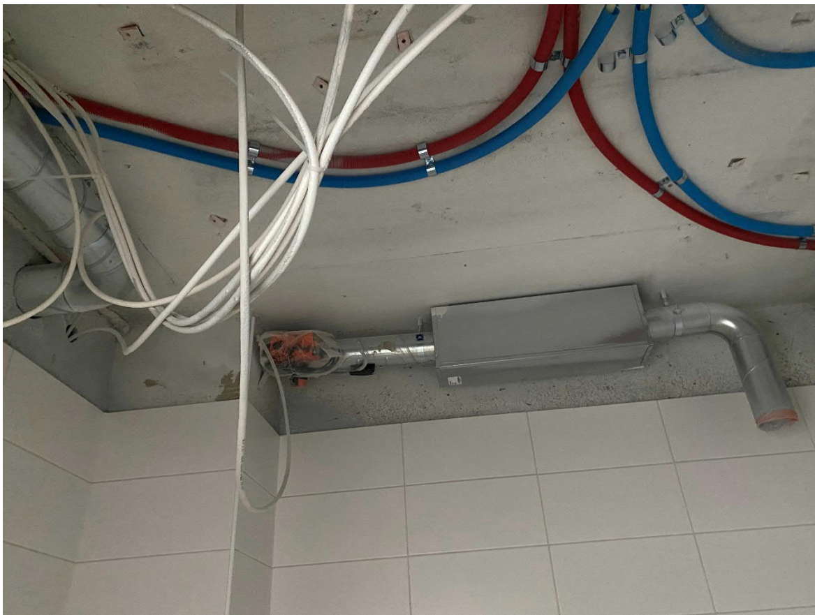
Kuva 6. Kohteen mallihuoneen LVI asennukset kylpyhuoneen katossa
