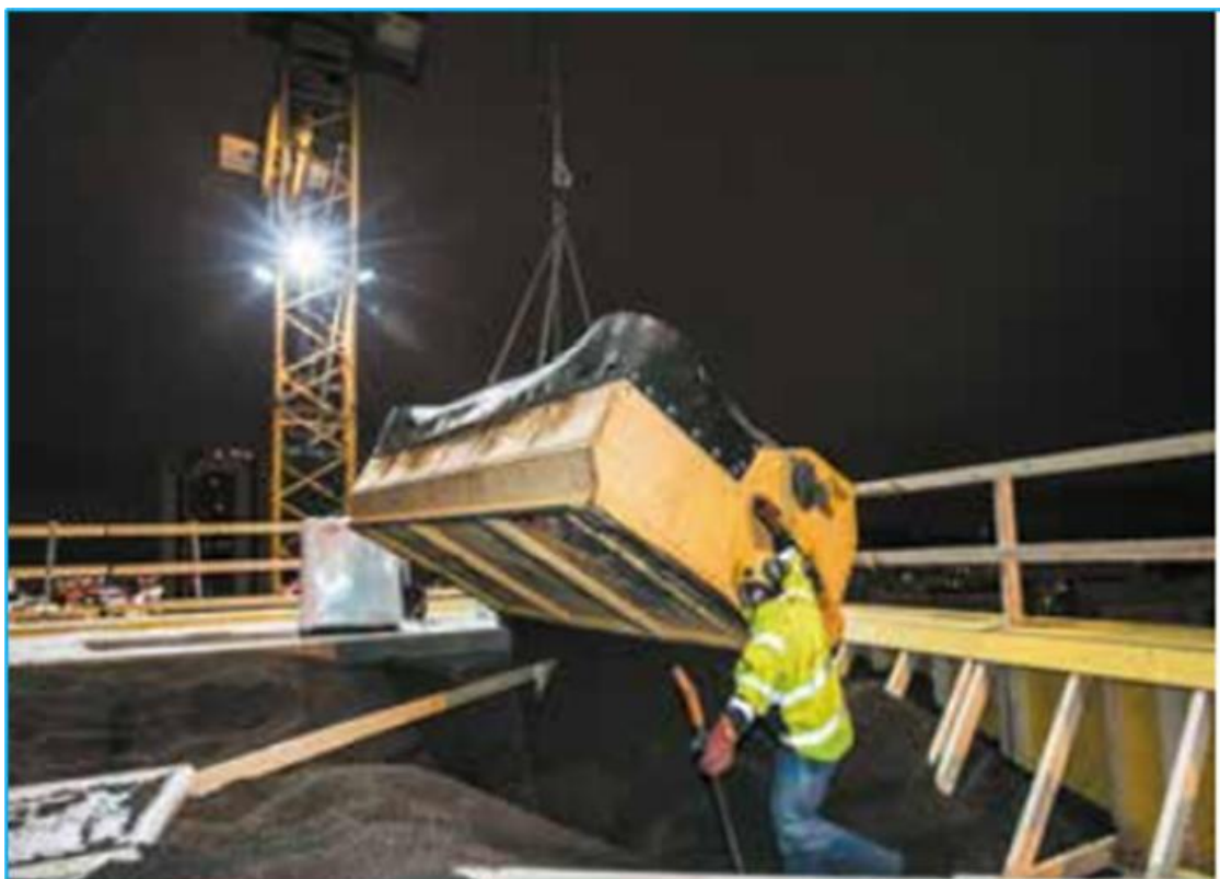
Kuva 6. Kevytsora "valetaan" katolle yleisimmin nostoastian avulla. (1, s. 8)
