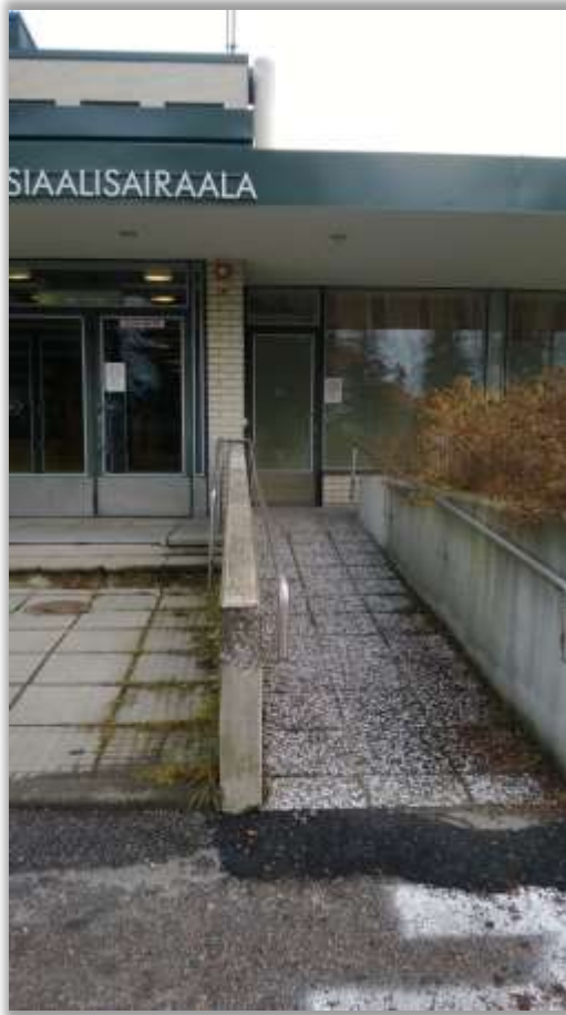
KUVA 3: Luiska pääsisäänkäynnin yhteydessä
