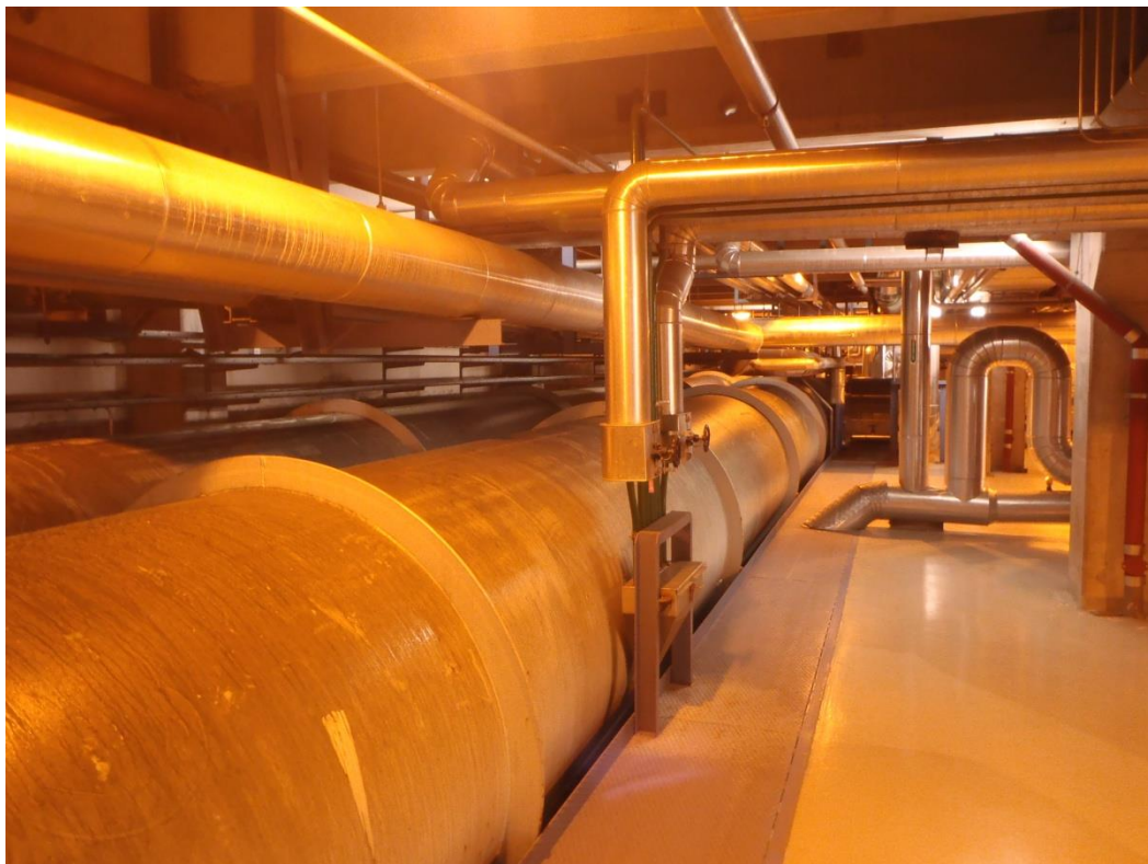
Kuva 3. Meri-Porin voimalaitos tarvitsee valtavan määrän jäähdytysvettä, joka käy ilmi laitoksen merivesiputkista (Matias Kivelä)
