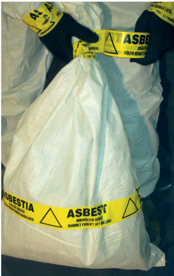
Kuva 7. Asbestijäte pakattuna siihen tarkoitettuun pussiin. (Mäkelä 2019, 43)
