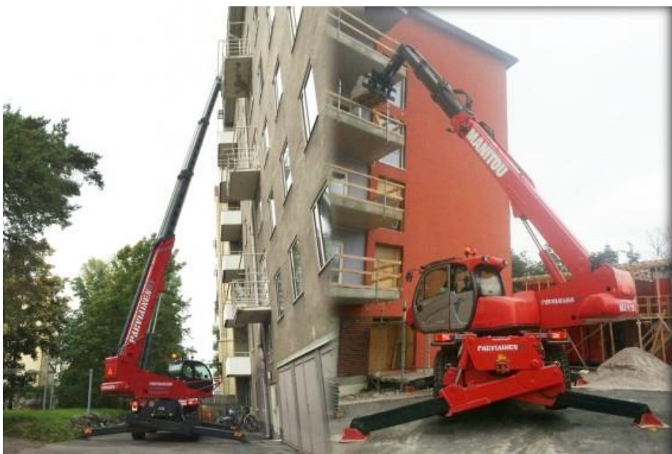
Kuva 13. Kurottaja nostamassa tavaraa parvekkeen kautta. [6.]
