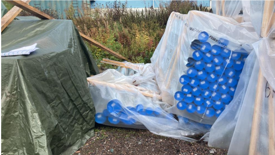
Kuva 6. Väärin säilötty IV-putki häkki romahtanut toisen häkin painosta.
