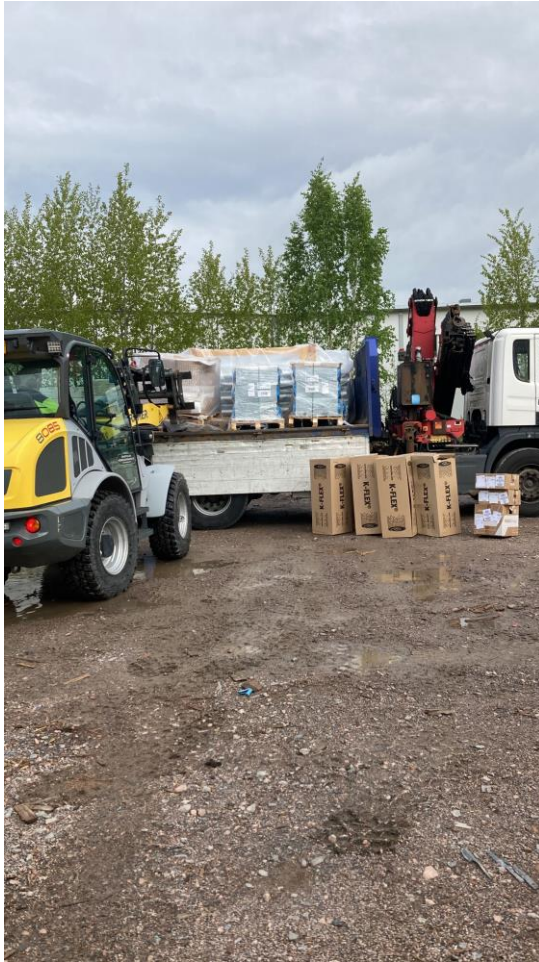
Kuva 7. Kramer kuormaajalla lastataan materiaalia välivarastolla.
