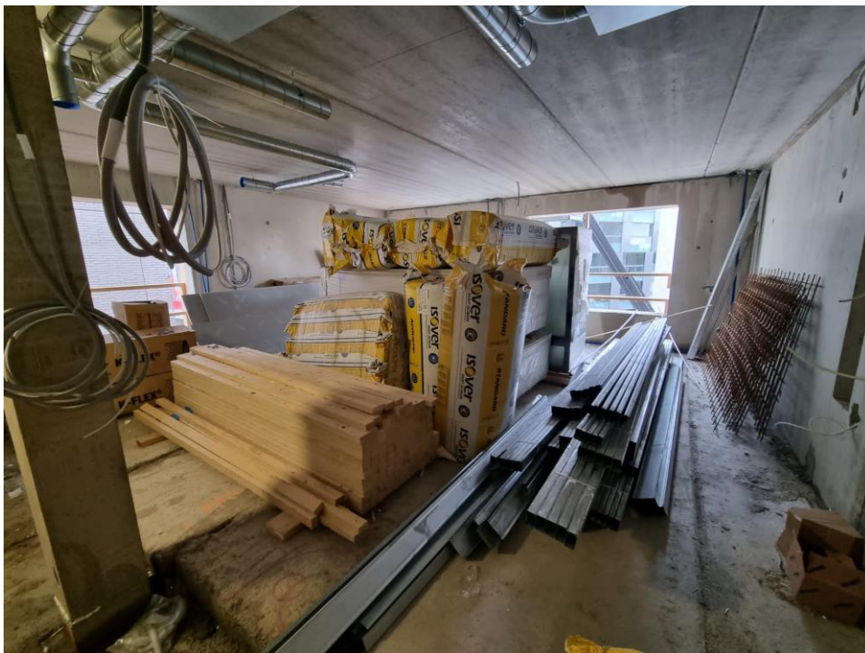
Kuva 12. Lincolninakio 4 työmaan materiaalin säilöntää.
