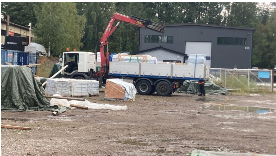
Kuva 8. Hiab-auto lastaamassa välivarastolta tavaraa.
