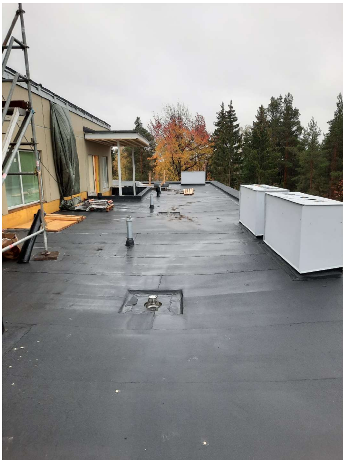
Kuva 9 Helsingin Erika pintakermi hitsattuna (Kuva: Eemil Suikkanen 2022)
