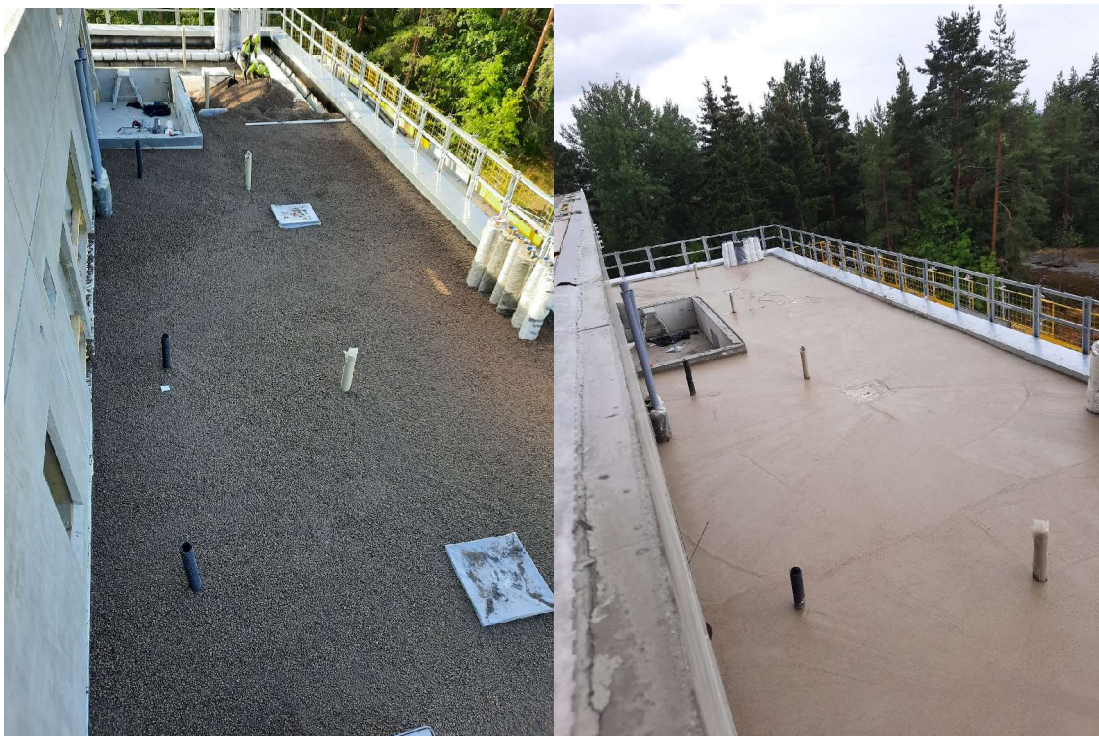
Kuvat 7 ja 8 Vasemmalla kevytsoran levitys ja oikealla kallistusvalun pinta. (Kuva: Eemil Suikkanen 2022)
