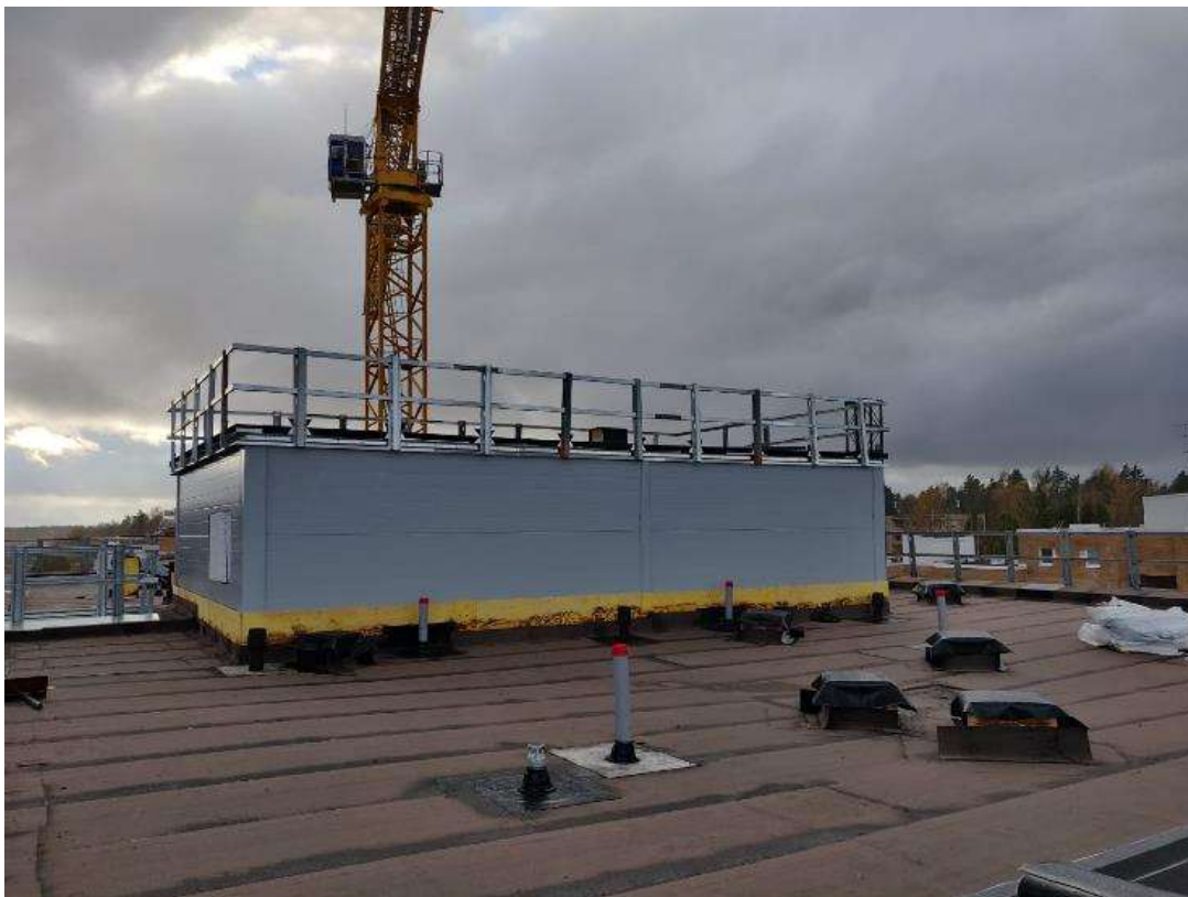
Kuva 6 Asolan Wilja aluskermi hitsattuna (Kuva: Eemil Suikkanen 2021)
