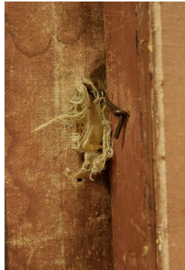
Kuva 19. Kulissi 1 oven haka-kiinnitys (Penttinen 2022)
