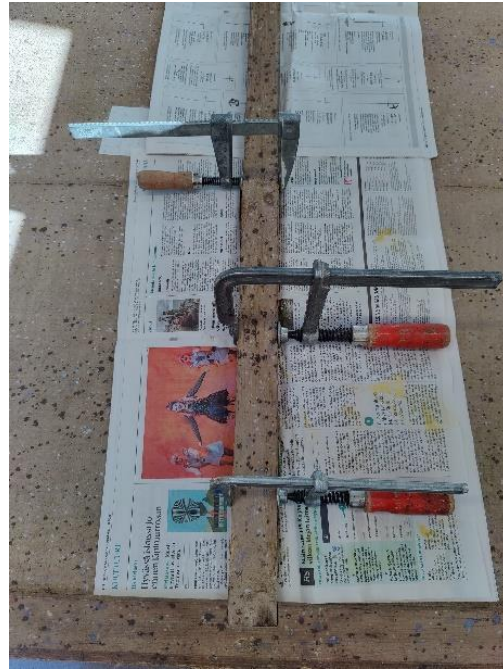
Kuva 44. Kulissi 3 haljennut tukipuu puristuksessa (Laasasenaho 2022)
