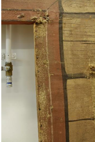
Kuva 21. Kulissi 2 kulumat ikkunanpokassa (Penttinen 2022)
