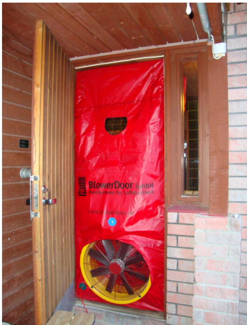
Kuva 2 Ilmatiiviysmittauslaitteisto asennettu oviaukkoon
