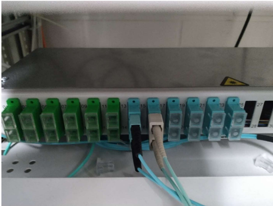
Kuva 26. Kuva jakamosta otettu, jossa 9500 core-kytkimeltä rimalle tuleviin liittimiin kytketty kytkimelle menevä kuitujohtopari.
