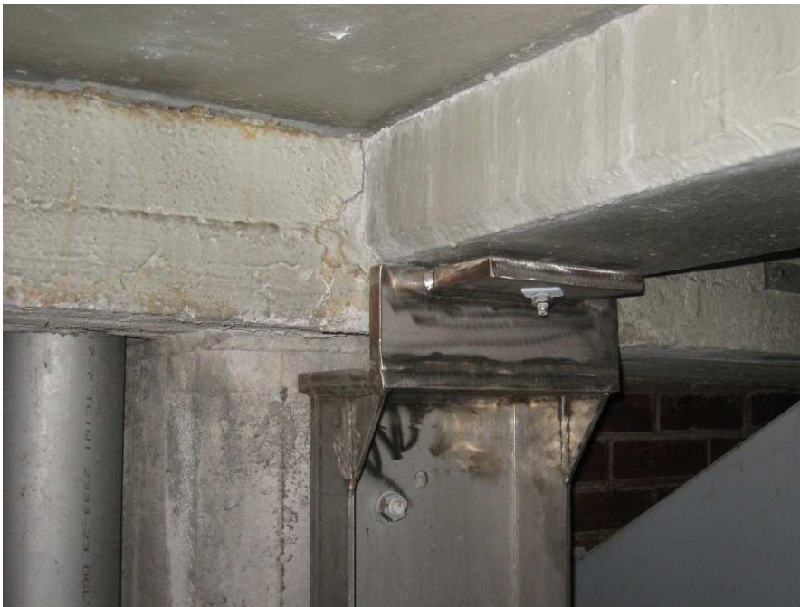
Kuva 12. Välikaton leukapalkkien vahvistus
