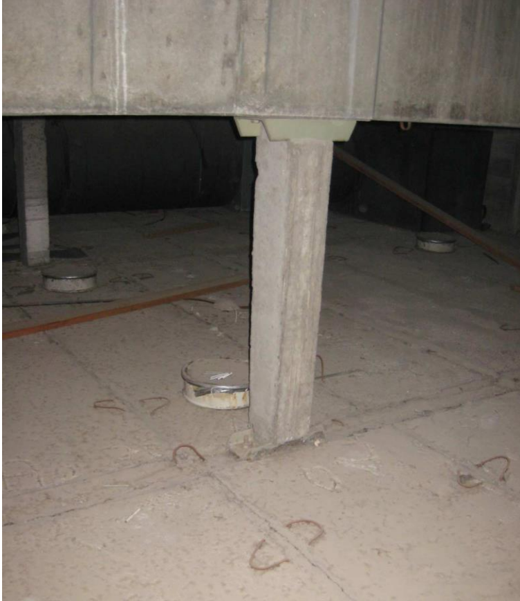
Kuva 13. Välikaton vetosauvat olivat hyvässä kunnossa
