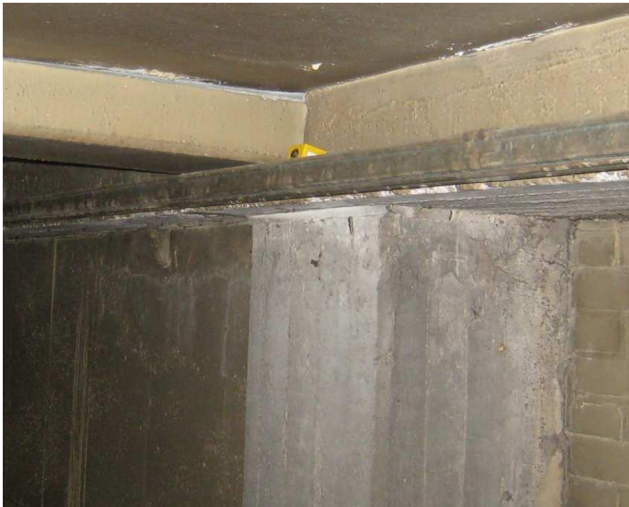
Kuva 5. Tinytag-mittausyksikkö asennettuna paikalleen välikaton alle.
