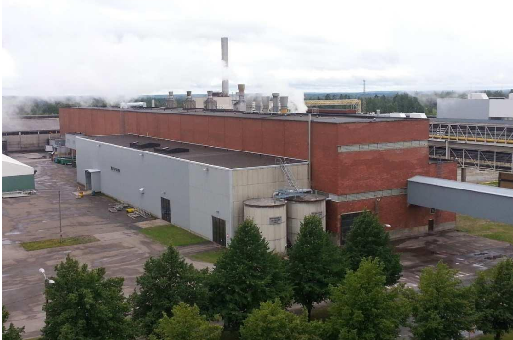
Kuva 2. Kaukaan sellutehtaan kuivausosasto 1.
