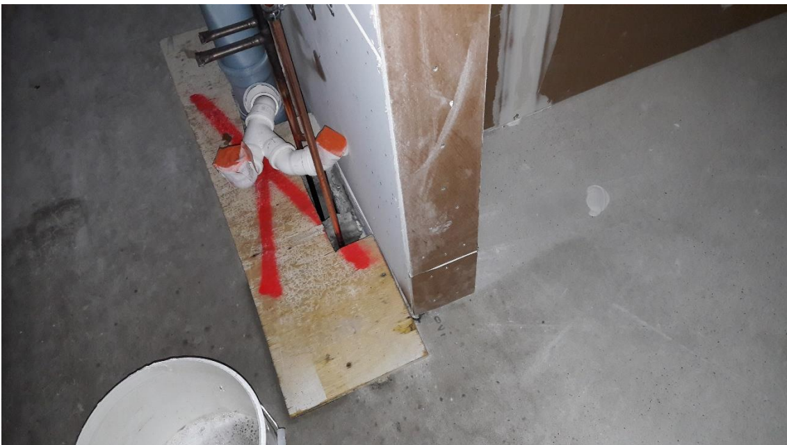
Kuva 22. Samanlainen välipohjan talotekniikkaläpivienti aukkosuoja asennettuna
