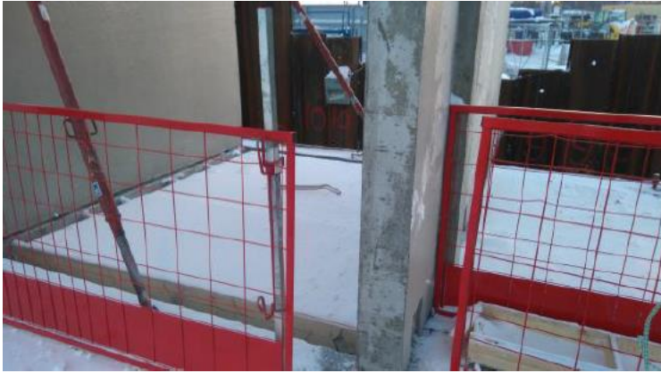
Kuva 25. Kaide on poistettu, jotta pääsee työpisteelle. (SRV 2016)
