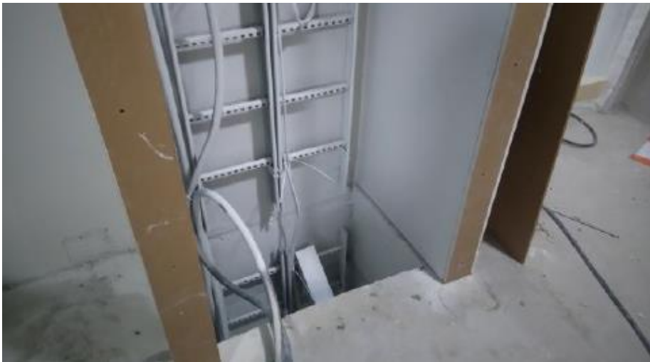
Kuva 23. Aukkosuoja on poistettu.
