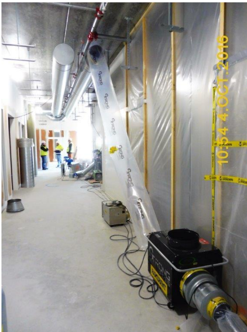
Kuva 5. Ilmastointiasennusaikainen kanavan ylipaineistaja (SRV 2016)
