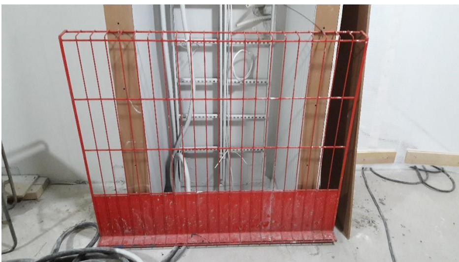
Kuva 24. Edellisessä kuvassa olevaan paikkaan asennettiin kaide.
