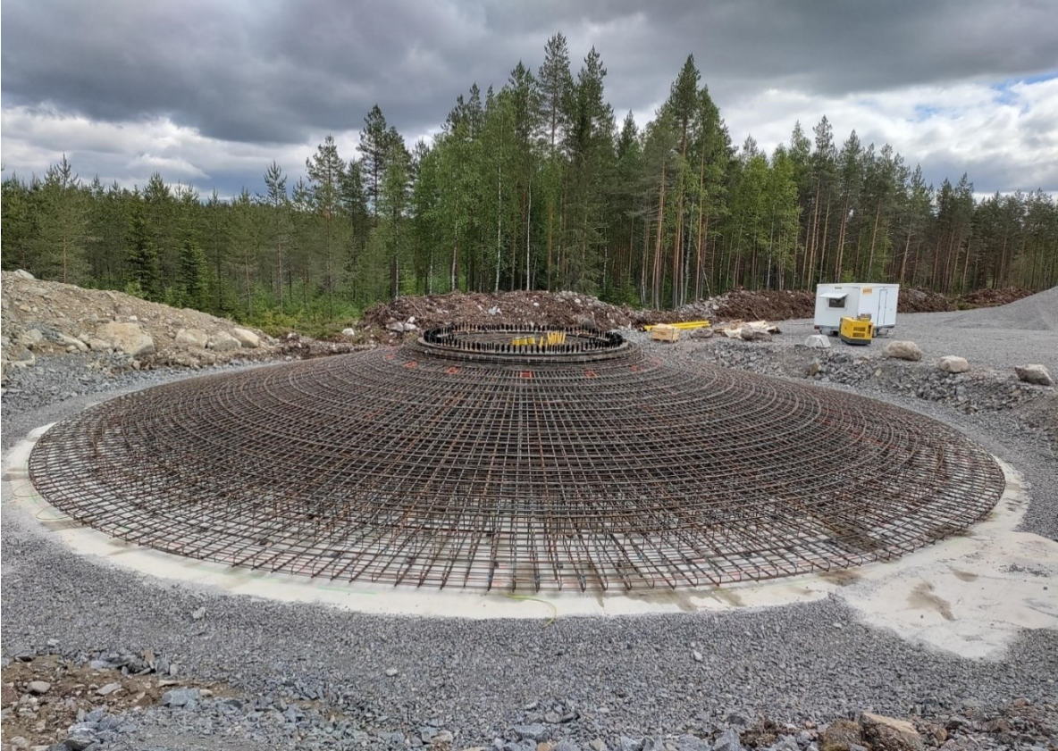
Kuva 3. Gravitaatioperustuksen raudoitus.
