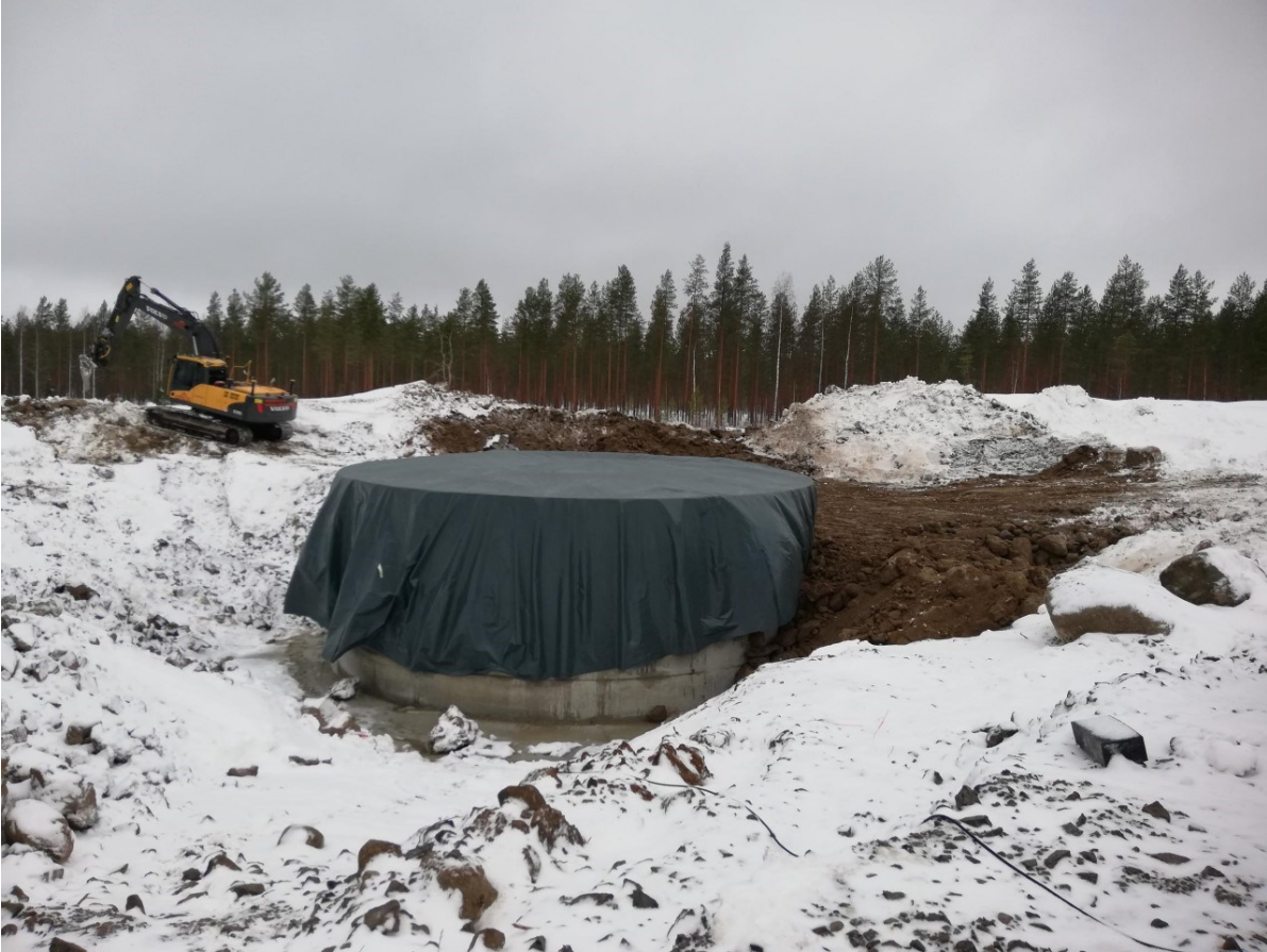
Kuva 5. Kallioankkuriperustus suojattu peitteellä.
