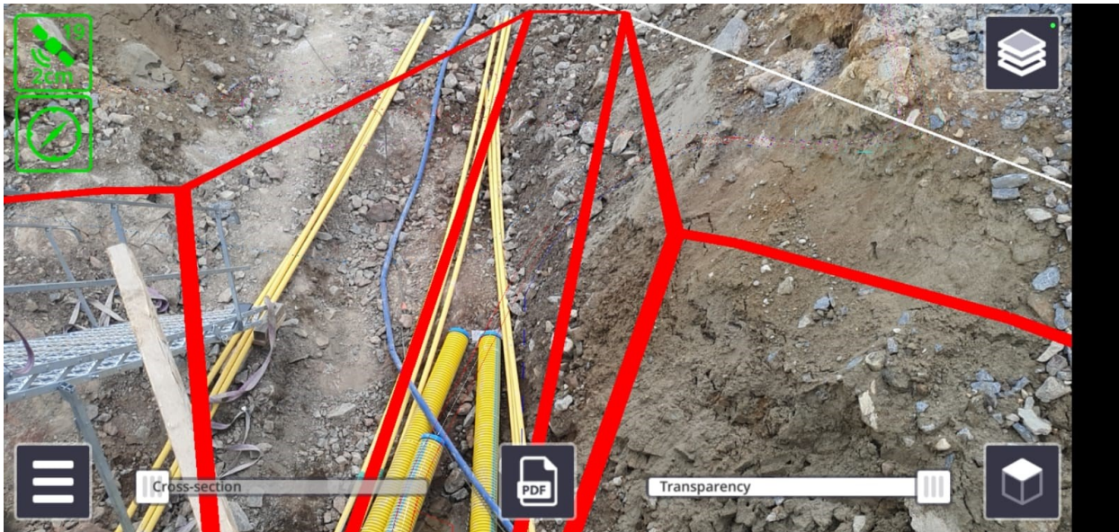
Kuva 8. Varausputkien sijainti Sitevisionissa.
