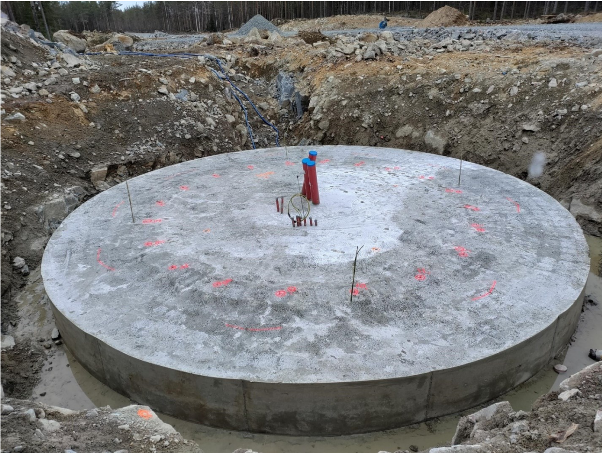
Kuva 13. Korotusvaluun tehdyt merkinnät.
