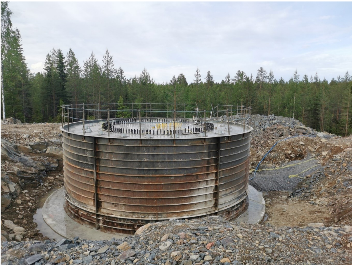
Kuva 2. Kallioankkuriperustuksen järjestelmämuotti.
