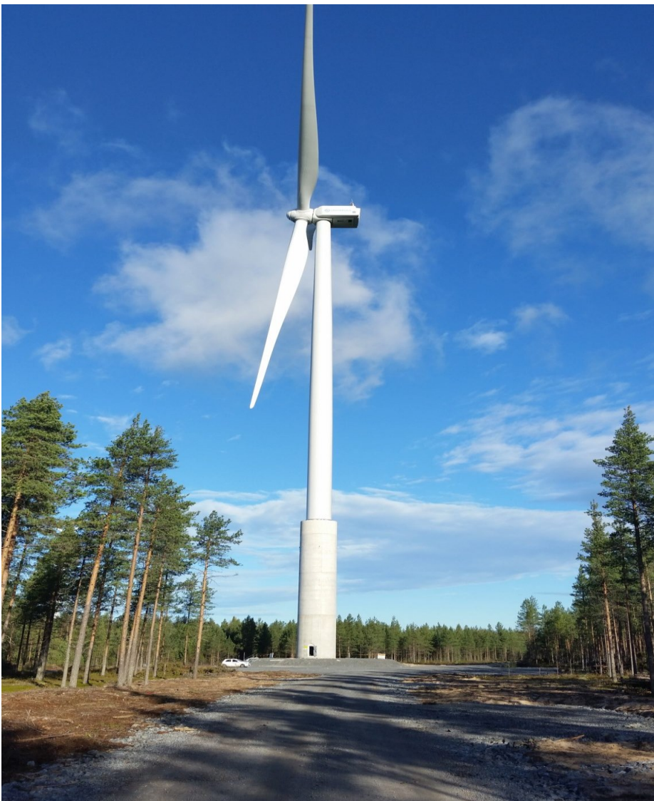
Kuva 1. Tuulivoimalan hybridimalli (KSBR, i.a.).
