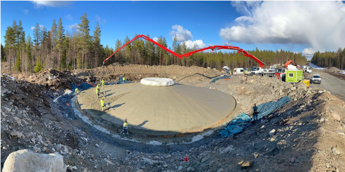
Kuva 4. Gravitaatioperustuksen betonointi (KSBR, i.a.).
