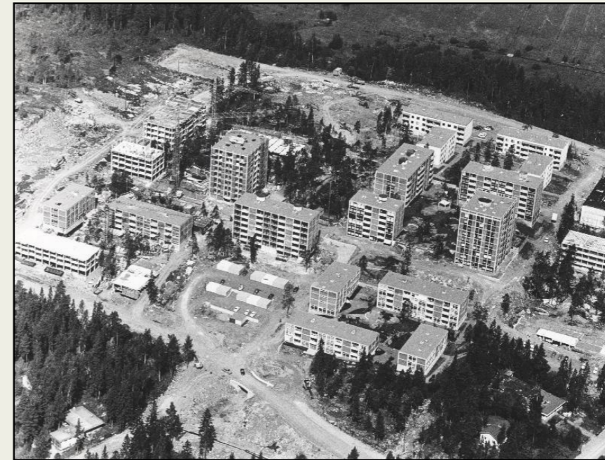
Kuva 9 Ilmakuva Olarista rakenteilla
