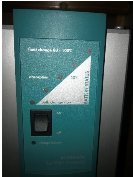
Käyttöakkujen laturi ja lataustaso-mittari
