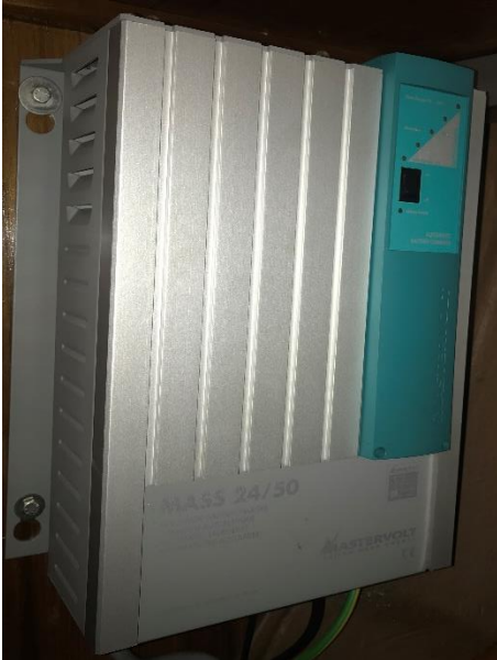
Käyttöakkujen laturi ja lataustaso-mittari
