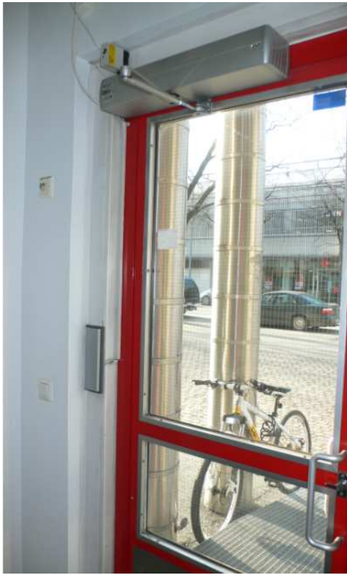
Kuva 9. Sähköinen ovenavausmekanismi (kuvannut Timo Urpulahti).
