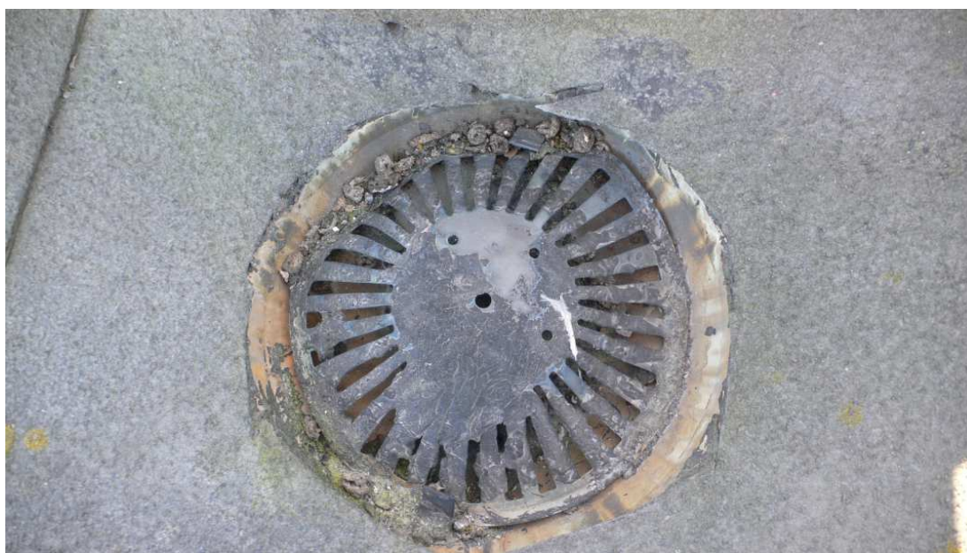
Kuva 16. Kattokaivo (kuvannut Timo Urpulahti).
