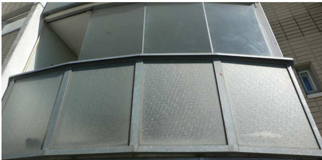
Kuva 12. Parvekkeesta ulkoapäin (kuvannut Timo Urpulahti).
