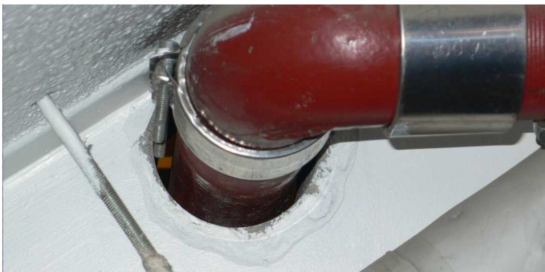
Kuva 28. Putken läpimenoaukko (kuvannut Timo Urpulahti).
