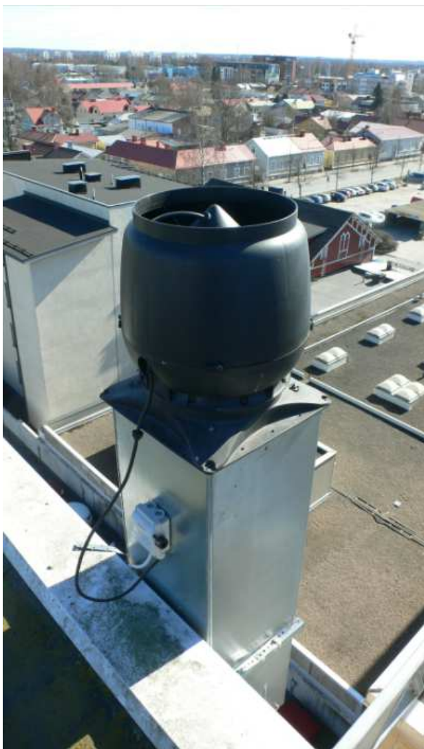
Kuva 26. Huippuimuri (kuvannut Timo Urpulahti).
