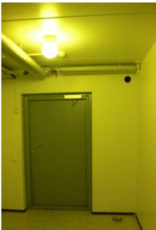
Kuva 11. Pyörasuojan takaovi (kuvannut Timo Urpulahti).
