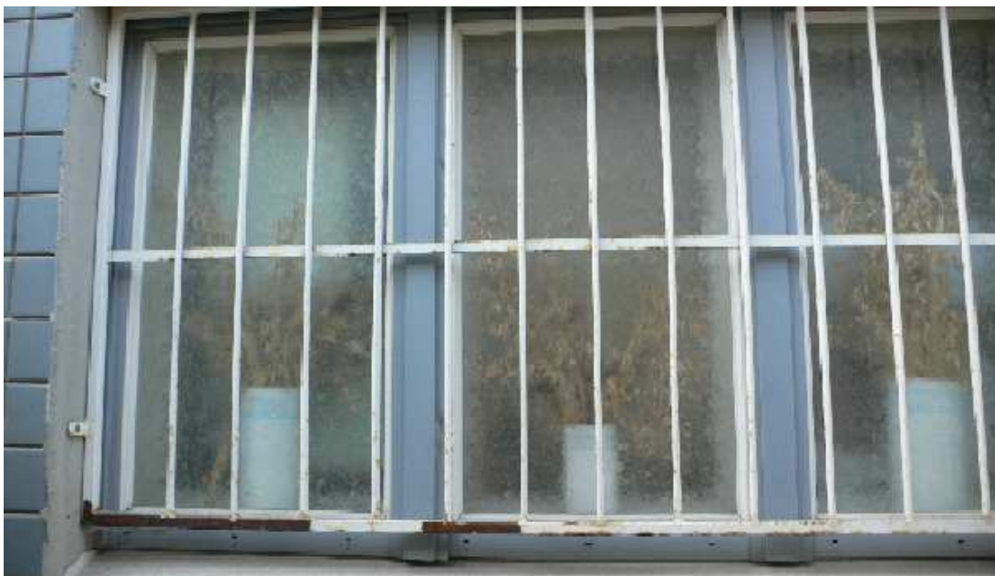
Kuva 5. Liiketilän ruostuneista kaltereista (kuvannut Timo Urpulahti).
