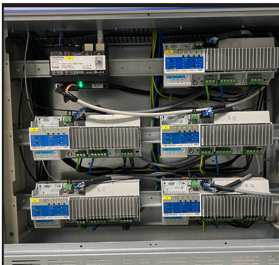
Kuva 27. Keskukseen asennettuna prosessori ja vaihehimmentimet. Kuvan alareunassa näkyy ilmanottoaukko kennolle, jossa vaihehimmentimet sijaitsevat.
