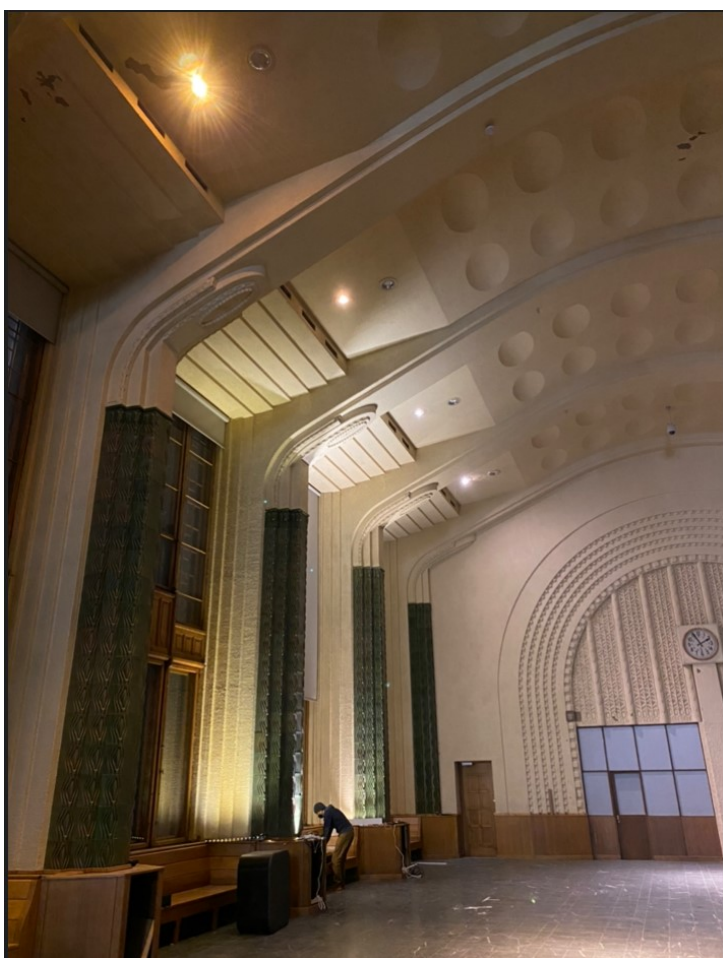
Kuva 23. Kuva pilarien ja kattovalaisimien koevalaistuksesta, jonka suunnitteli Matti Syrjälä, Sweco Oy. Kokeella pyrittiin selvittämään, mikä värilämpötila ja valokeila sopii tilaan parhaiten.
