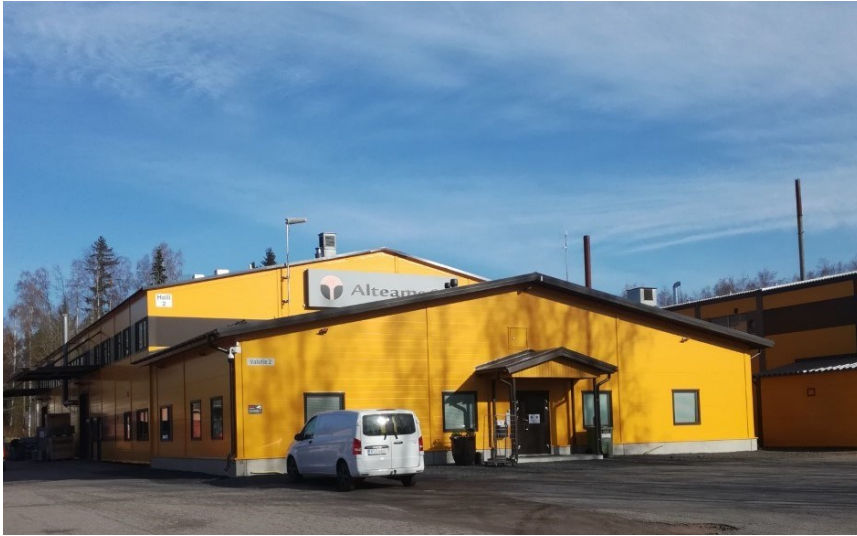
Kuva 1. Alteams Finland Oy Lopen alumiinivalimon toimistorakennus.
