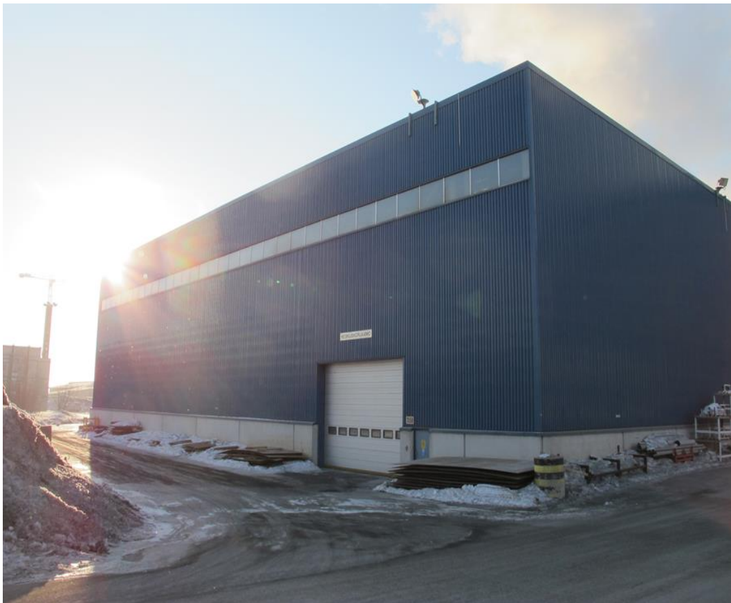
Kuva 1. Keskuskorjaamon ulkosivu (Reinikainen 2011).
