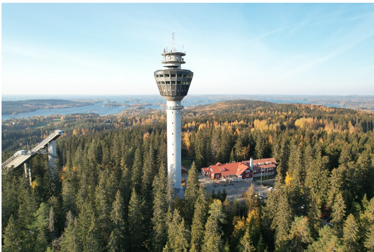
KUVA 9. Puijon torni (Markkanen 2021)
