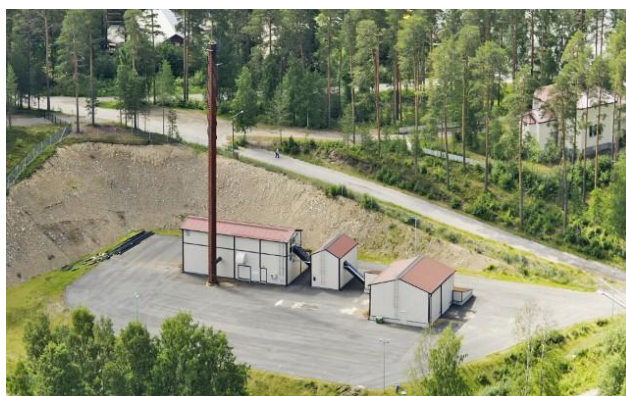
Rautalammen biolämpökeskus, Papintie 6, 77700 Rautalampi
