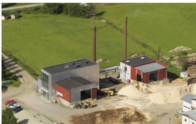
Kiuruveden voimalaitos, Sahatie 4, 74700 Kiuruvesi
