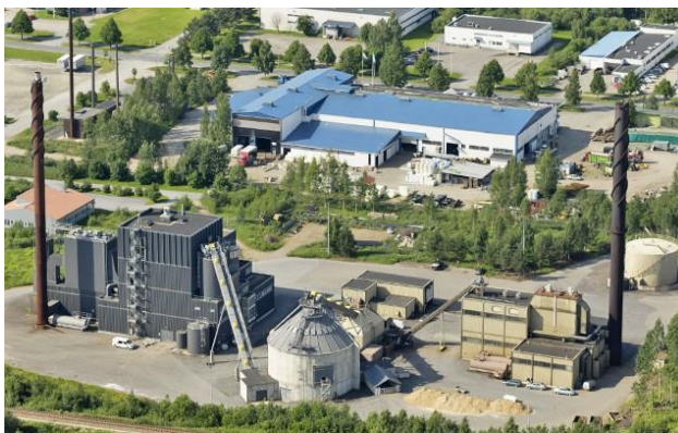
Iisalmen voimalaitos, Energiaukuja 3, 74120 Iisalmi
