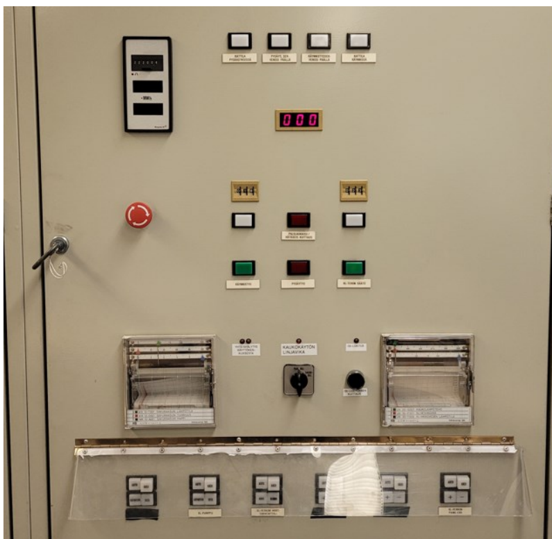
Kuva 23. VT5 vanhan automaatiokeskuksen ovi
