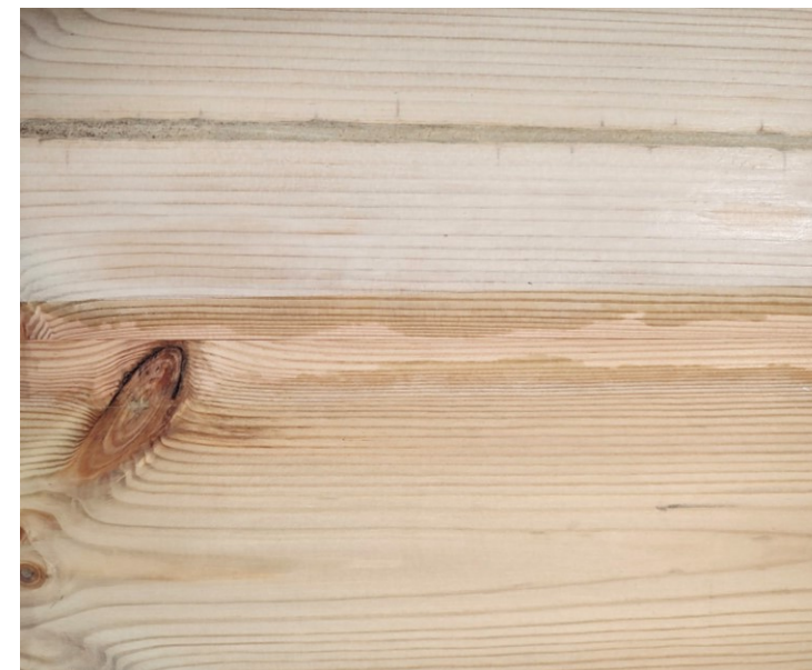
KUVA 23. Trämaxin päälle levitetty suojaava aine (PASANEN 2022)
