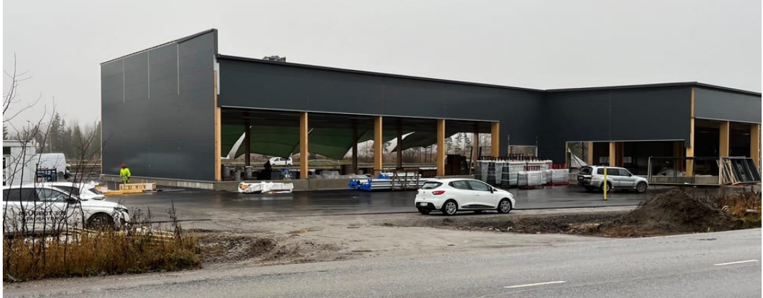
Kuva 4 Autoverkkokauppa Raision uuden autotalon rakennustyömaa marraskuussa 2022 (Autoverkkokauppa.fi, 2022)
