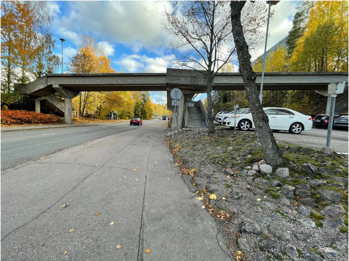
Kuva 40. Rasinkadun ylikulkukäytävä, jonka purkamista on suunniteltu.
