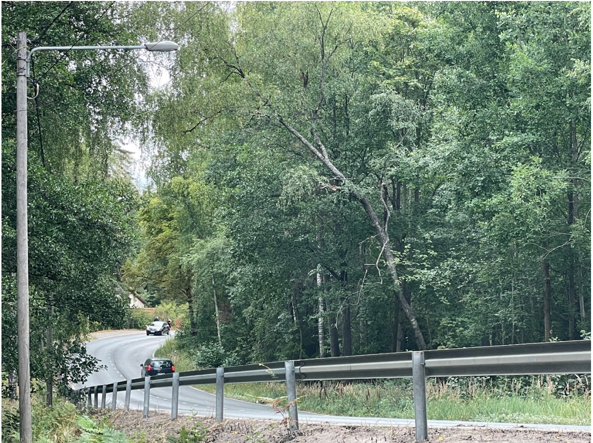
Kuva 8, Huonokuntoinen puu aiheuttaa vaaran autotielle.
