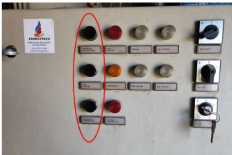
Figur 4 Knappar att kvittera fel från värmecentralen
