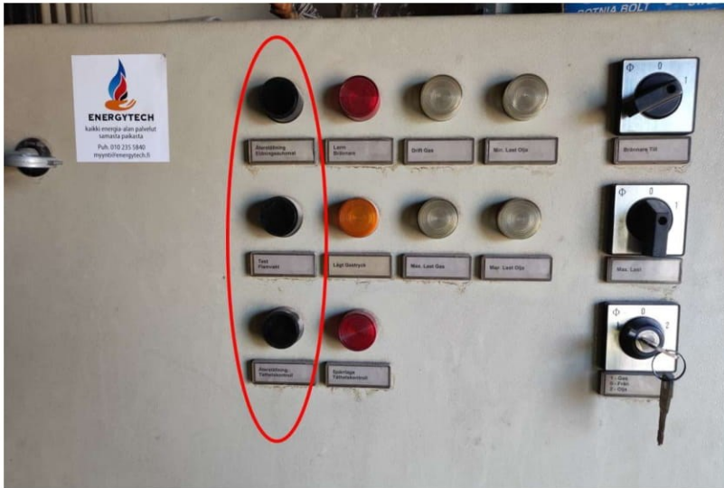
Figur 4 Knappar att kvittera fel från värmecentralen
