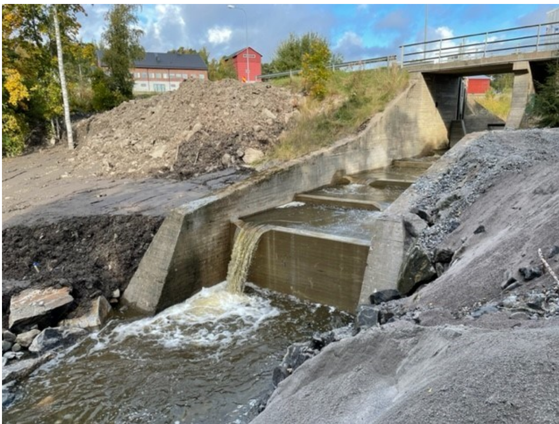
Kuva 8. Valetut betonikynnykset, joiden yläpinnassa alivirtaama-aukot.
