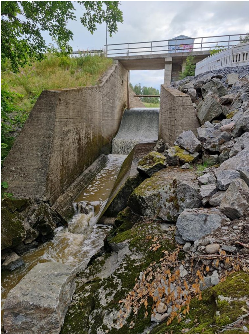
Kuva 4. Yleiskuva Hintsan padosta ennen muutostöitä.
