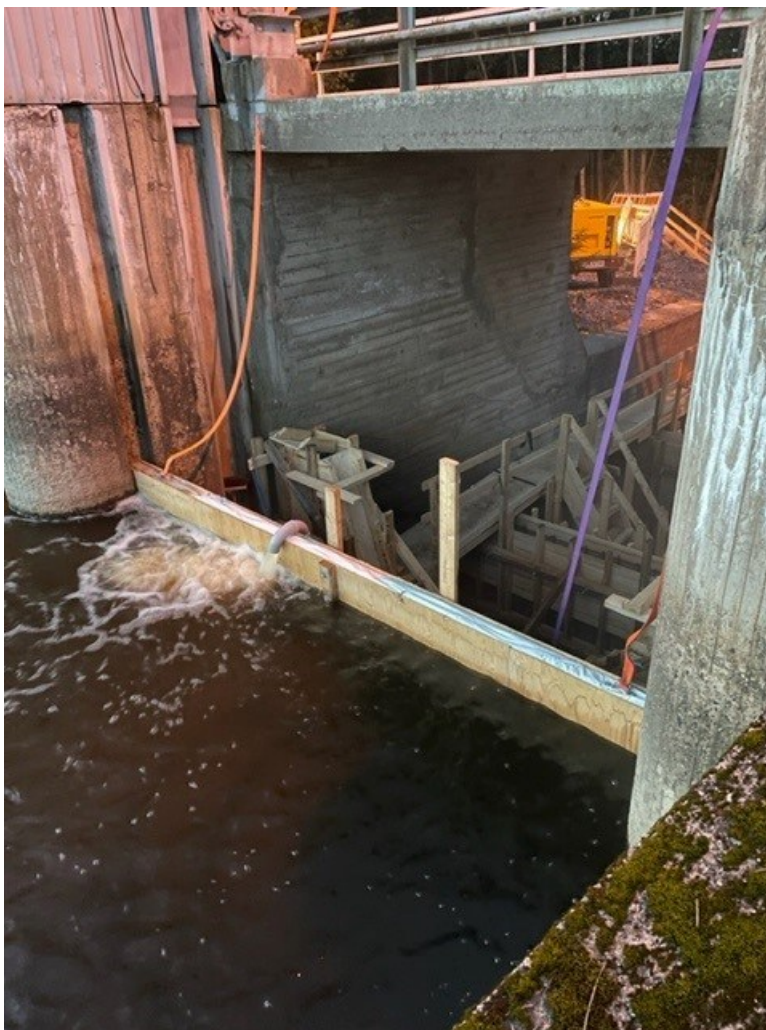
Kuva 10. Työaikainen settilankku virtaamien hallintaan.
