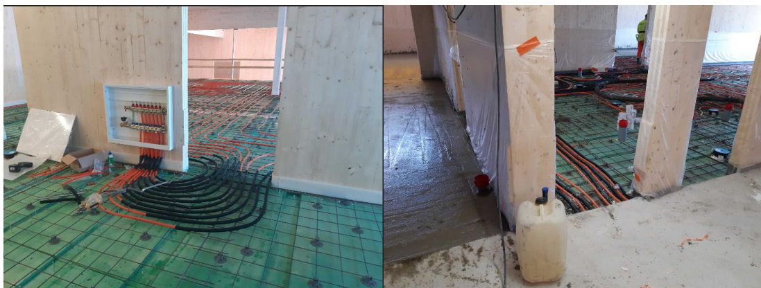
Figur 2 & 3. Exempel på CLT-bjälklag innan betongplatta gjuts på. (Bild av Michael Honkala)
