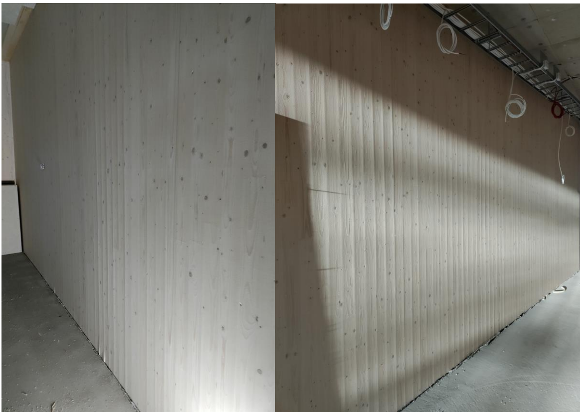
Figur 10 & 11. Exempel på deformationer av lameller på ytan i CLT-element. (Bild av Michael Honkala)
