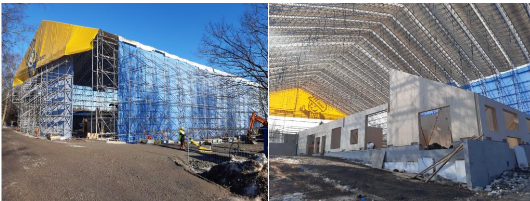
Figur 5 & 6. Väderskydd på ett CLT-bygge. (Oy Rakennuspartio) Resning av CLT stomme under väderskydd (Oy Rakennuspartio)
