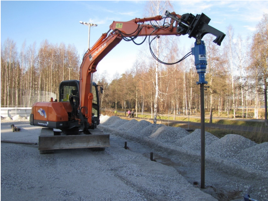
Kuva 25. Kaivinkoneasenteinen paalutusyksikkö (Paalupiste Oy:n kuva-arkisto)
