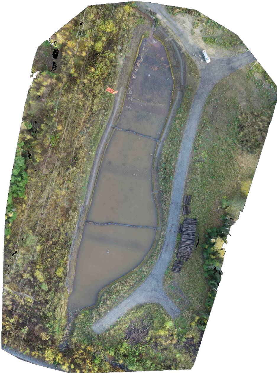
Kuva 5. Ilmakuva Karikon hulevesialtaasta 12.10.2022. Vesi tulee altaaseen kuvan ylälaidassa näkyvän tulo-ojan kautta. Altaan poisto sijoittuu kuvan alalaitaan. Kuvassa on selvästi nähtävissä pohjapadot sekä altaaseen sijoitetut rankaniput (kuva: Juha Vihavainen).
