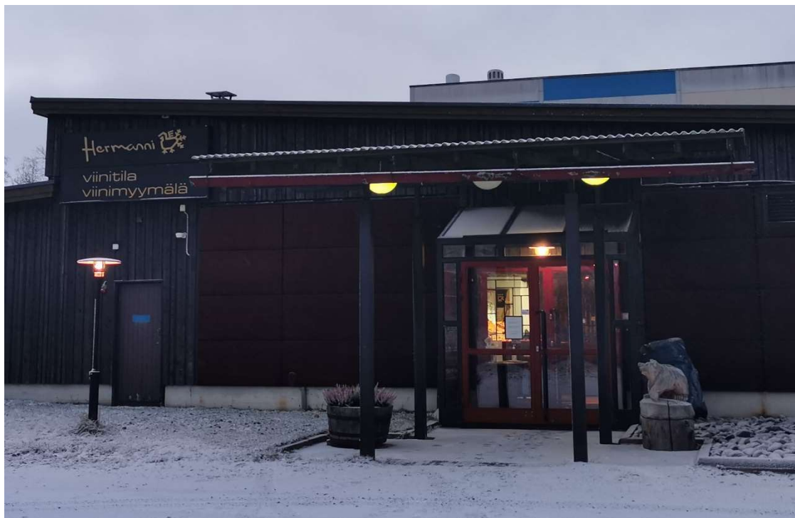
Kuva 1. Hermannin viinitilan viinimyymälän sisäänkäynti. (Kuva: Anniina Åke).
