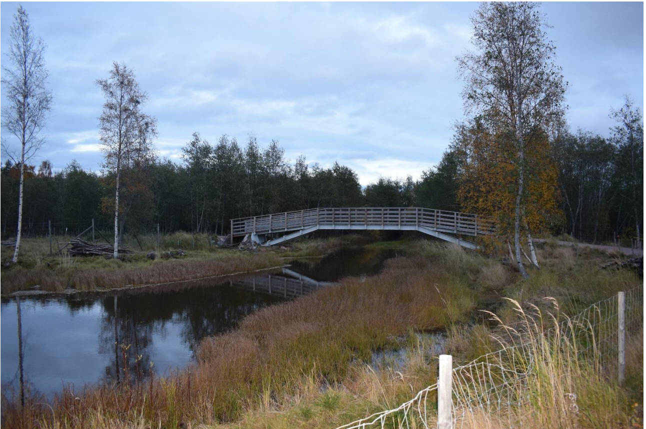
Kuva 16 Keihäsojan ylittävä silta
