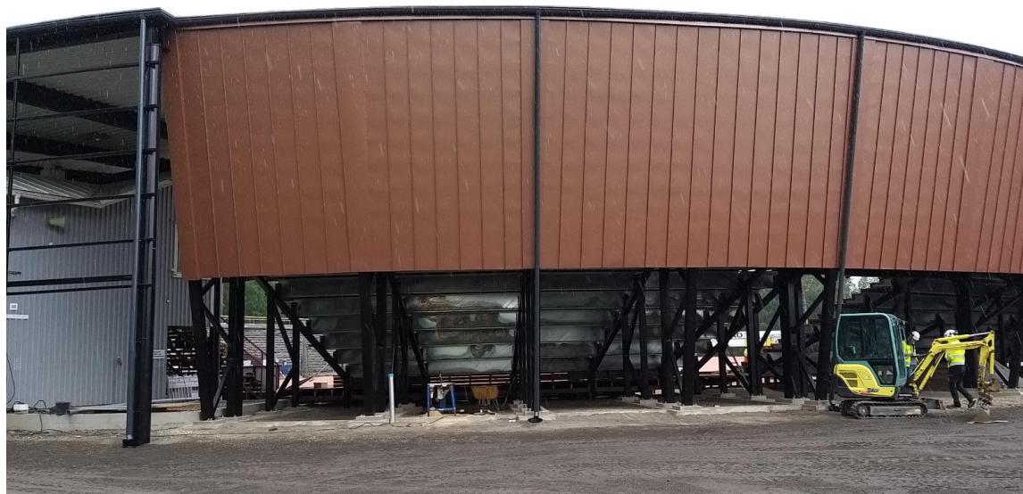
KUVA 9. Pystysaumattu julkisivupelti, Kiteen Rantakenttä (Vaakanainen 2020)
