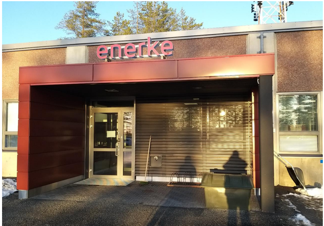
KUVA 13. Rei'itetty profiililevy sisäänkäynnin taustaseinässä (Vaakanainen 2020)
