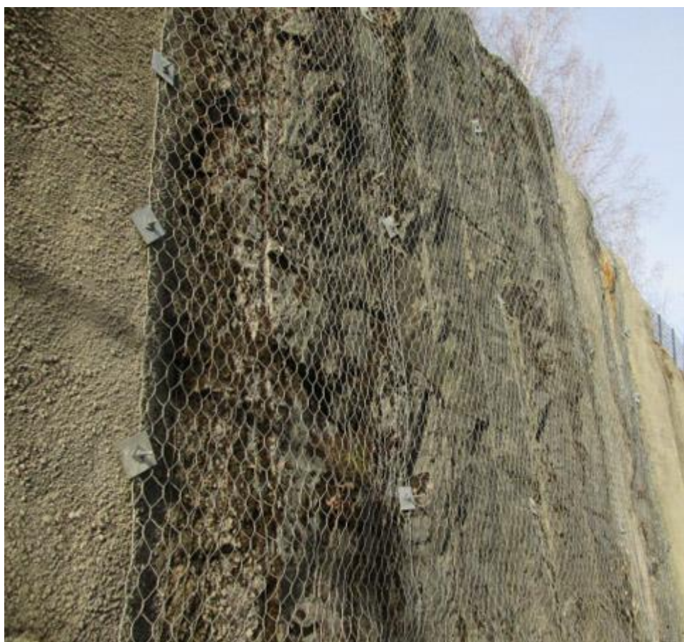
KUVA 5. Kallioverkkoa ja ruiskubetonia Malminkartanossa (Lujitustekniikka Oy julkaisuaika tuntematon)
