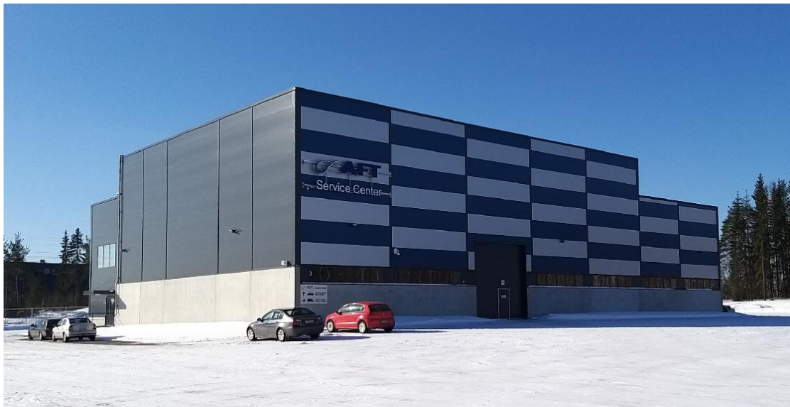
KUVA 7. Ruukki Sandwich-paneeli, tasoprofiilipinta, AFT Service Center, Varkaus, (Vaakanainen 2021)
