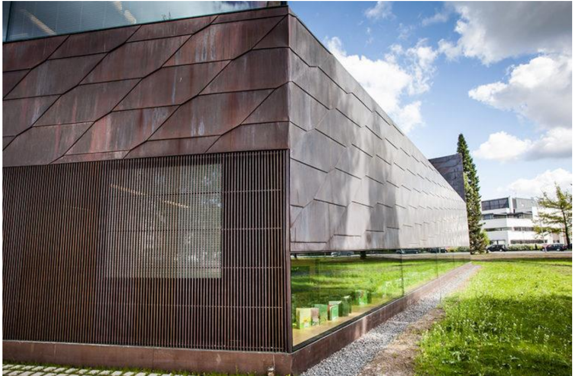
KUVA 15. Kupariset PS-P säleiköt ikkunaseinällä, Seinäjoen kirjasto (Alupro Oy julkaisuaika tuntematon)
