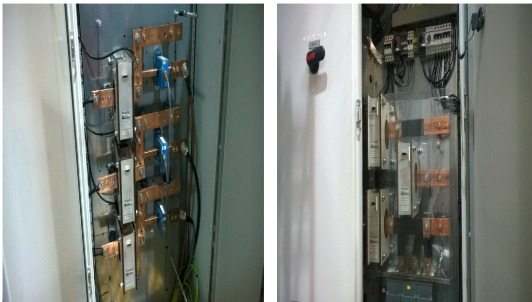
Kuva 11. Vasemmalla 600 A ja oikealla 1000 A virtamuuntajat.
