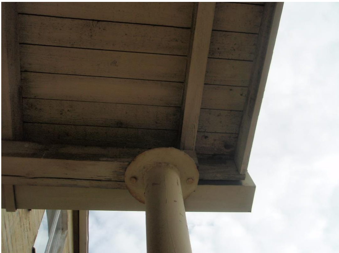
Kuvio 14. Länsipuolen puurakenteinen ulkokatos.
